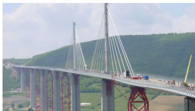
Viaduc de Millau: ReH \geq 355 & 460 MPa Pont mobile OTAN (Suède): ReH \geq 1100 MPa Pont Akashi Kaiko (Japon): ReH \geq 780 MPa
