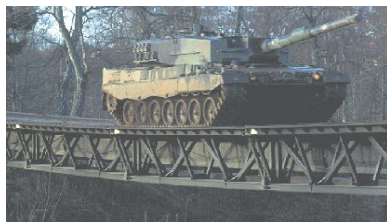
Viaduc de Millau: ReH \geq 355 & 460 MPa Pont mobile OTAN (Suède): ReH \geq 1100 MPa Pont Akashi Kaiko (Japon): ReH \geq 780 MPa
