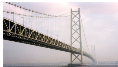
Viaduc de Millau: ReH \geq 355 & 460 MPa Pont mobile OTAN (Suède): ReH \geq 1100 MPa Pont Akashi Kaiko (Japon): ReH \geq 780 MPa
