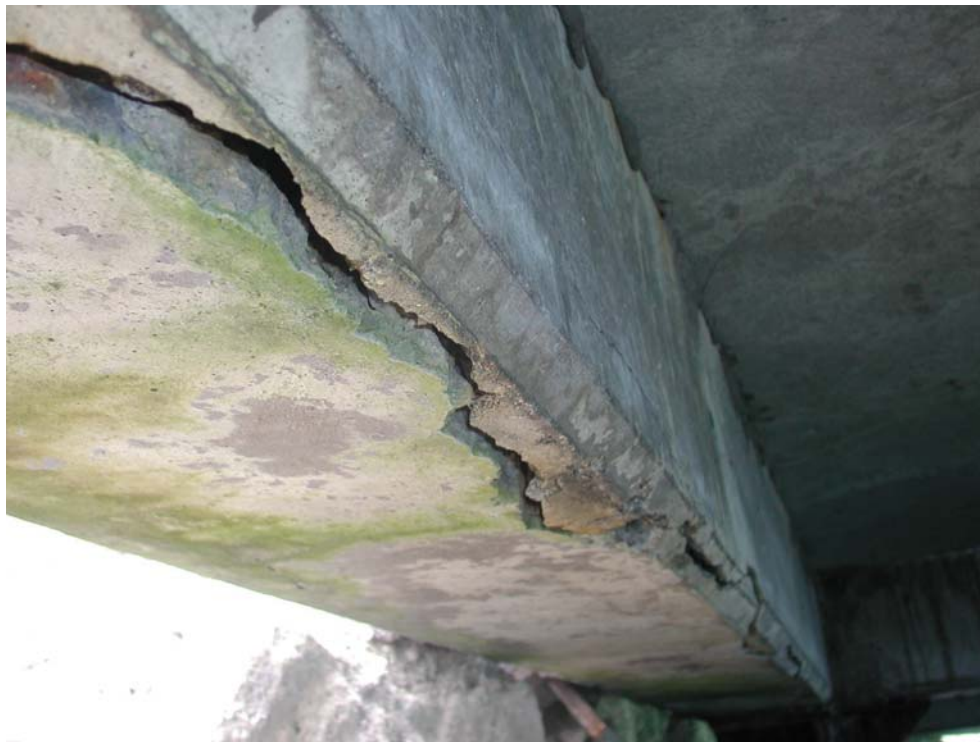
Poutre de tablier
