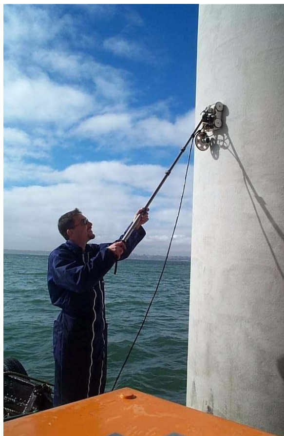
Diagnostic non destructif au radar
