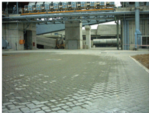
Photo n°5 : Zone réalisée en pavé dépolluant à base de ciment TX Aria
