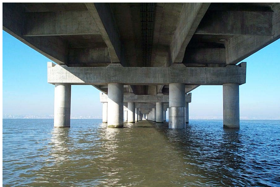
Figure 6 : Zone d'étude et de traitements préventifs Viaduc sud - Exemple d'une colonne « chemisée »
