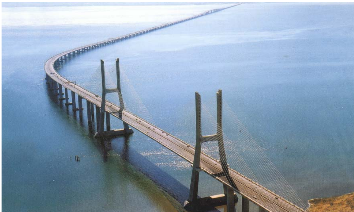
Figure 2 : Vue du pont principal à haubans
