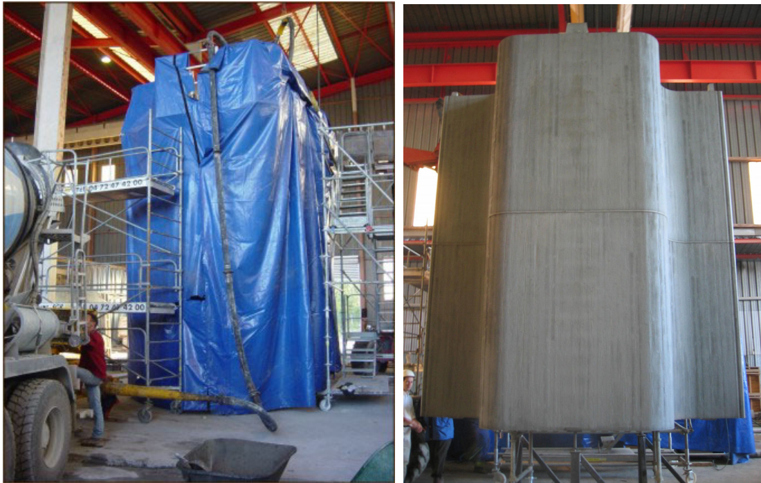
Fig 10 : Fabrication des voussoirs
