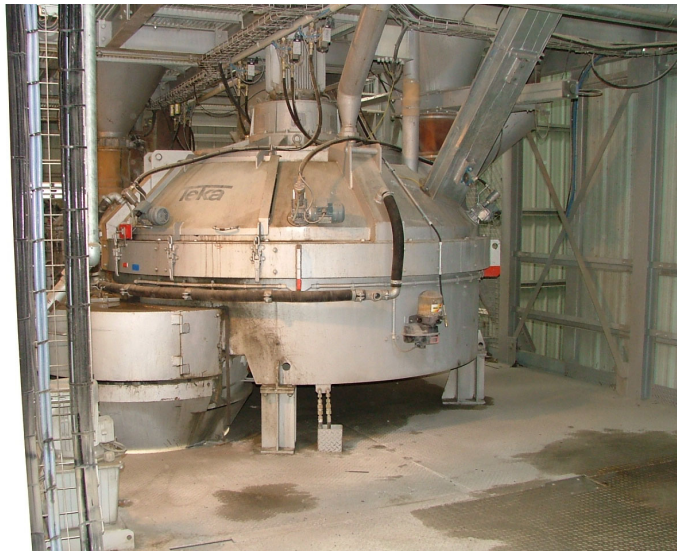
Fig. 5 : Malaxeur du site de préfabrication de Romagnieu
