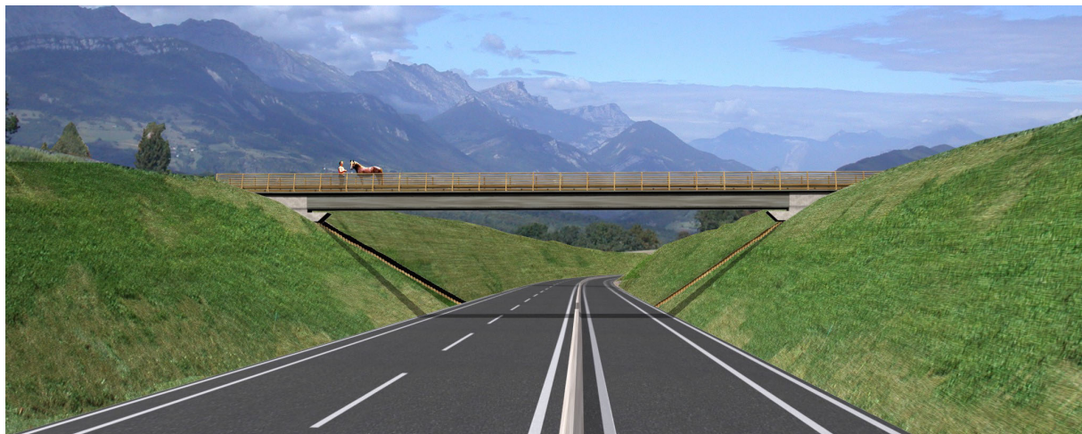
Fig 1 – Vue générale du PS34 sur l'autoroute A51
