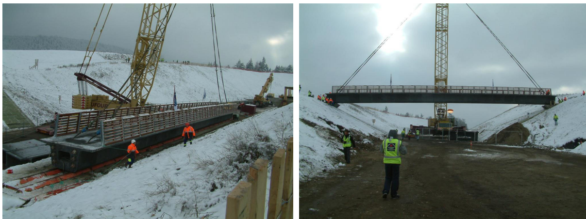
Fig. 12 : Mise en place à la grue
