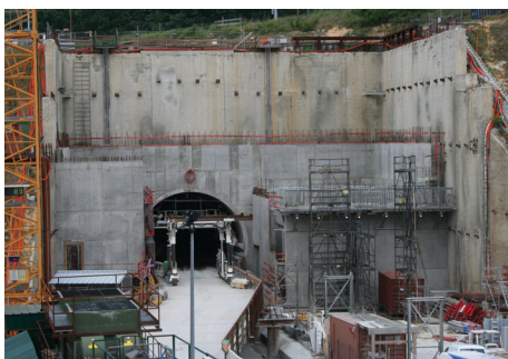
Figure 1 : Photo du chantier de l'A86 (chantier A1)
