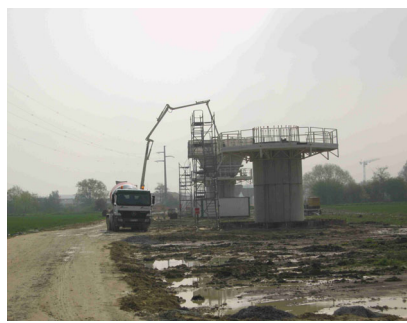
Figure 2 : Chantier du viaduc de Compiègne (chantier A2)
