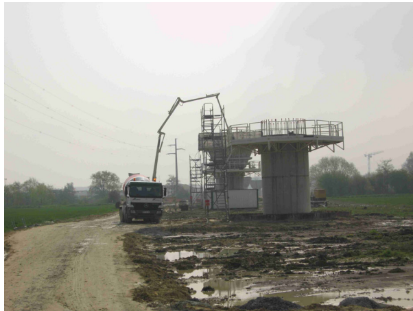
Figure 4 : vue du chantier du viaduc de Compiègne
