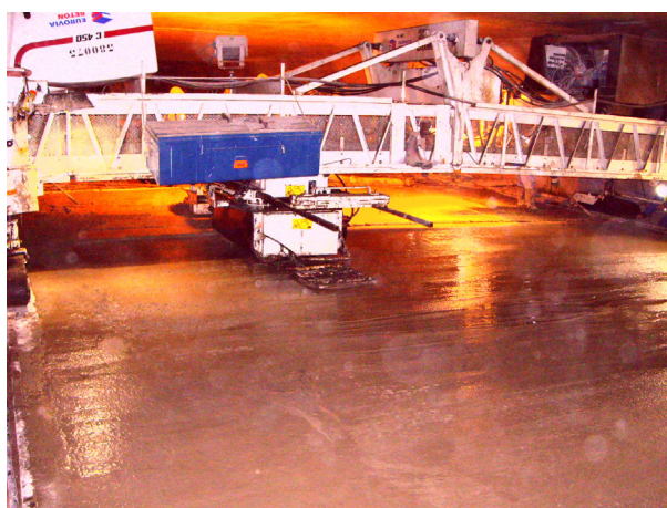
Figure 3 : vue de la finition de la dalle médiane du tunnel de l'A86
