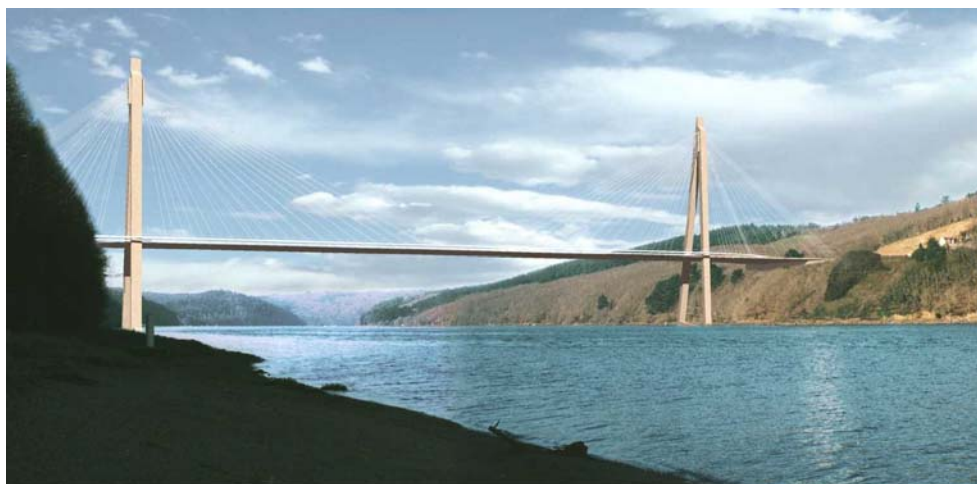
Figure 26 - Solution avec tablier encastré et pylône en forme de A dissymétrique
