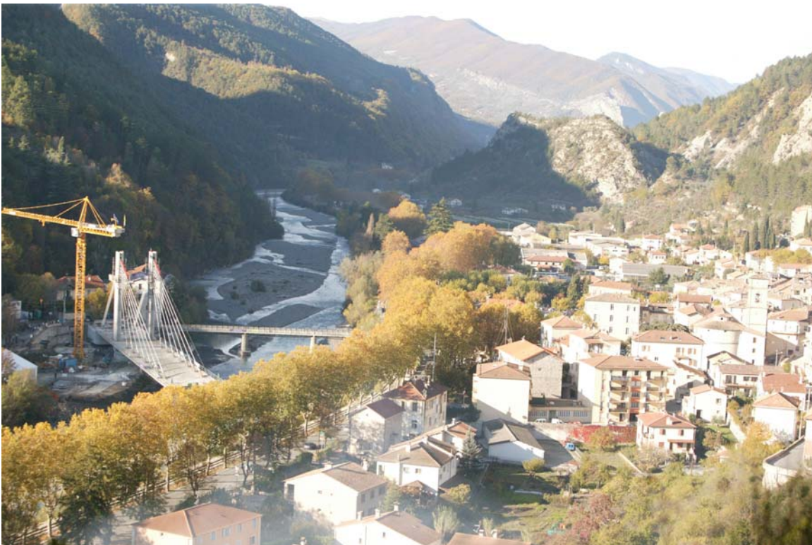
Figure 16a - Mise en place par rotation
