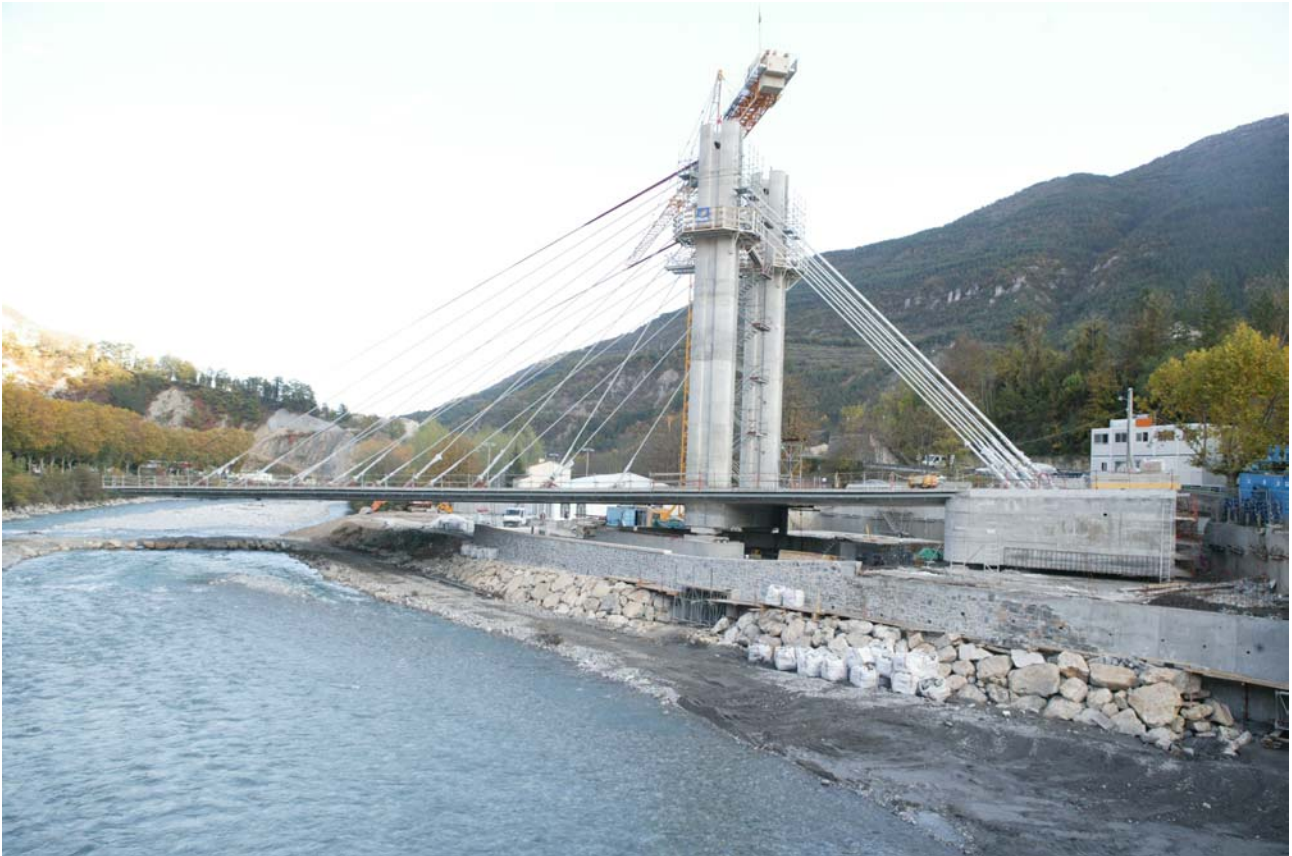
Figure 16b - Mise en place par rotation
