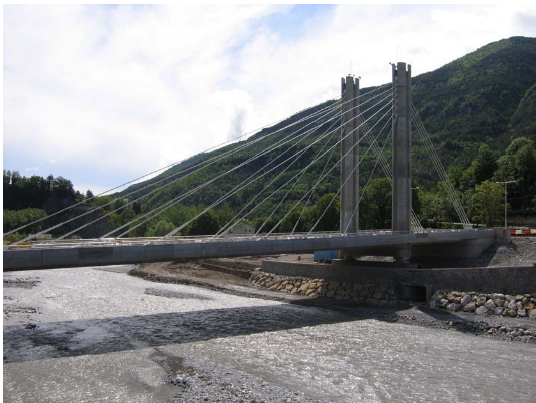
Figure 17 Aménagement en rive droite
