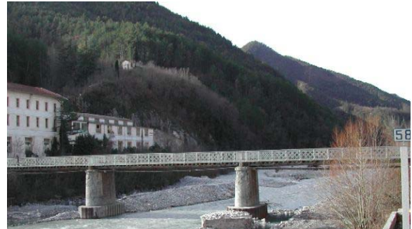
Figure 2 - Le pont du Brouchier sur le Var
