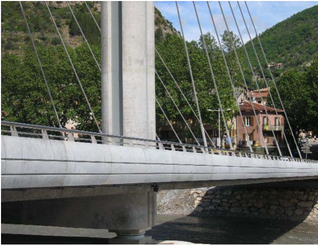
Figure 14 Corniche en béton
