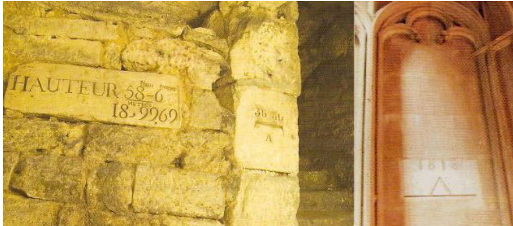
Figure 2 – Un repère de nivellement gravé dans une pierre (carrières à Paris) et sur un des piliers de la cathédrale de Bourges [2 et 3]
