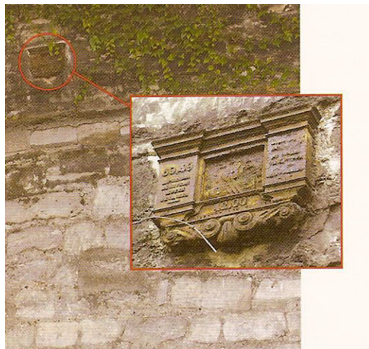
Figure 1 - Un repère de nivellement à Paris matérialisé par une plaque en fonte [3]
