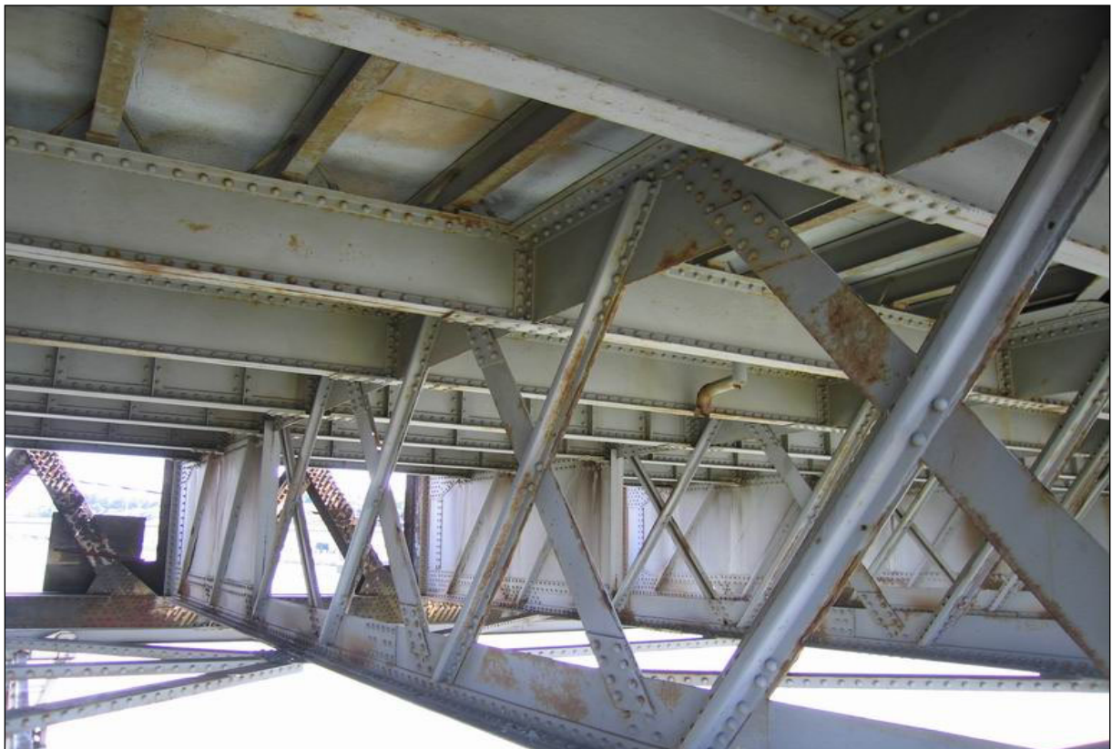
Pièce de pont courante à treillis
