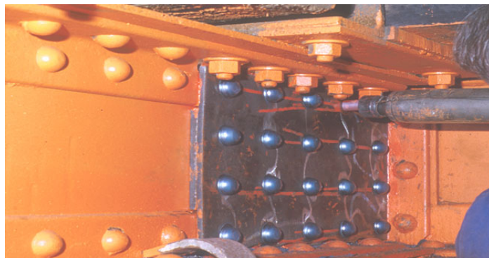
Réalisation d'une triplure
