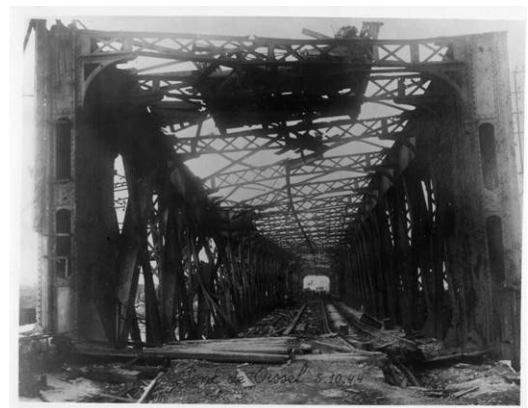
1944 : ouvrage bombardé par les alliés
