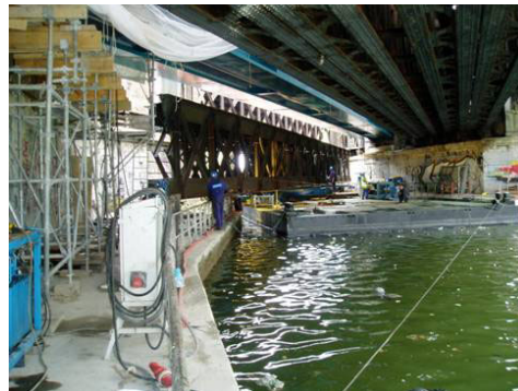
Découpe et évacuation du tablier ancien par dessous au milieu des circulations ferroviaires
