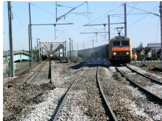
Circulation sur le tablier neuf en situation provisoire
