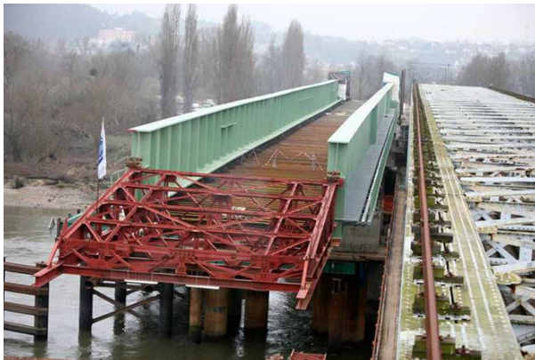
Charpente du tablier neuf en cours de lançage
