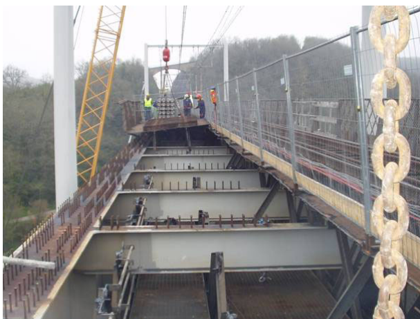
Dépose du demi-tablier de l'ouvrage ancien
