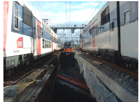
Découpe et évacuation du tablier ancien par dessous au milieu des circulations ferroviaires
