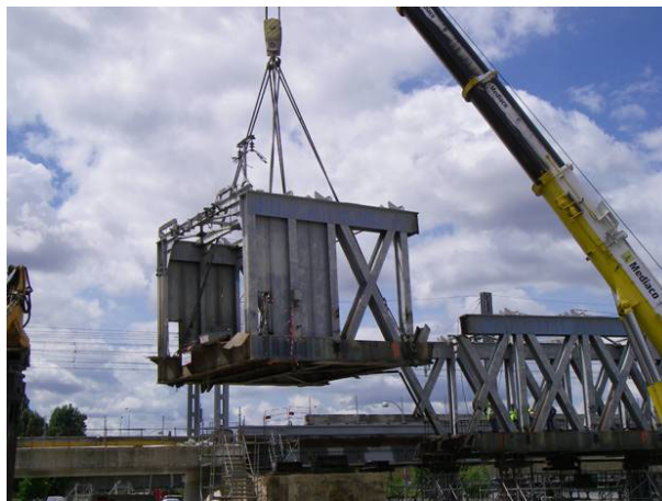
Démolition de l'ancien tablier
