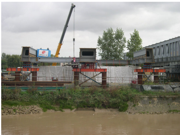
Charpente métallique du nouveau tablier
