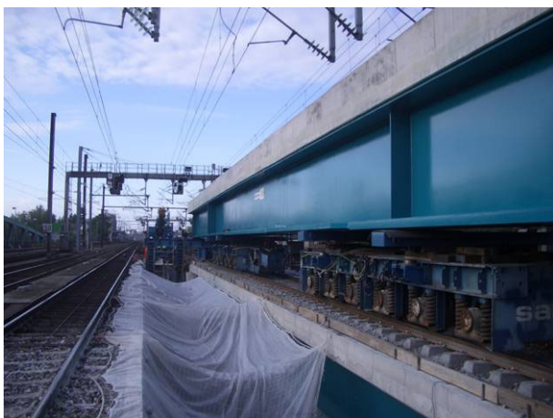
Amenée de la nouvelle travée
