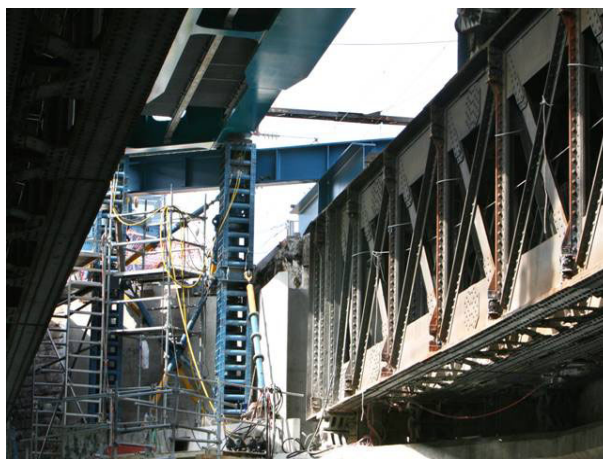
Dévérinage de la nouvelle travée sur tours d'étaisements
