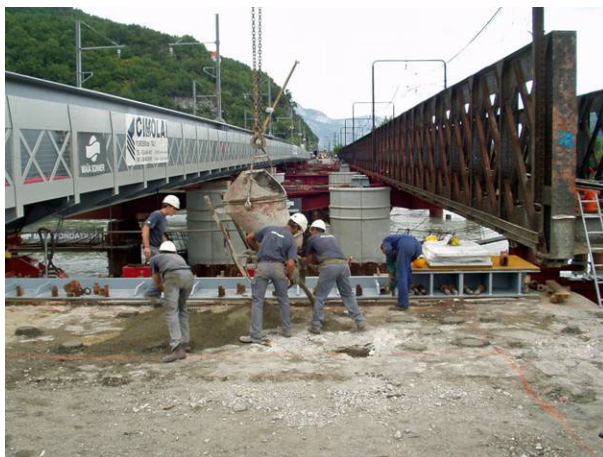
Préparation du chemin de ripage sur culées
