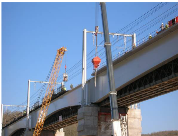
Bétonnage du demi-hourdis du nouveau tablier
