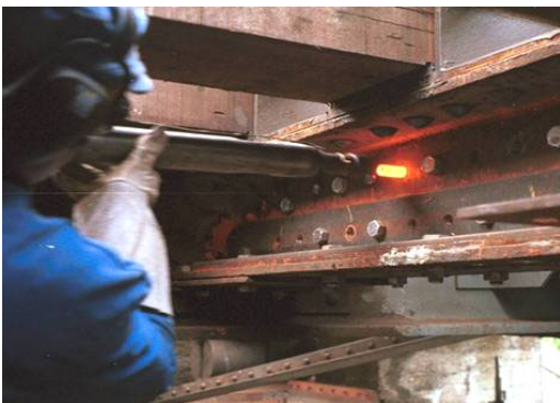
Remplacement de rivets
