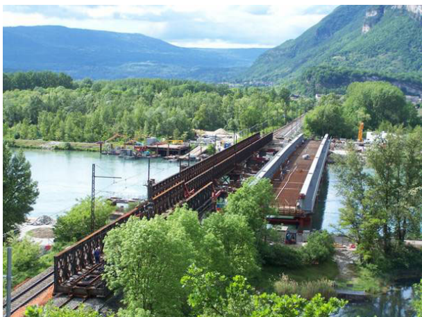
Vue générale : tablier neuf en construction et tablier ancien accidenté en cours de délançage
