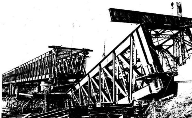
1940 : une travée effondrée, relevée et réparée en 1940-1941
