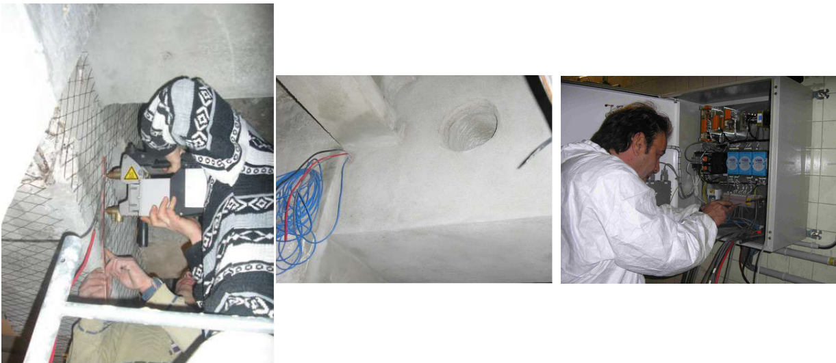
Photo 1 : Illustration du traitement de protection cathodique (crédit photo Freyssinet)
