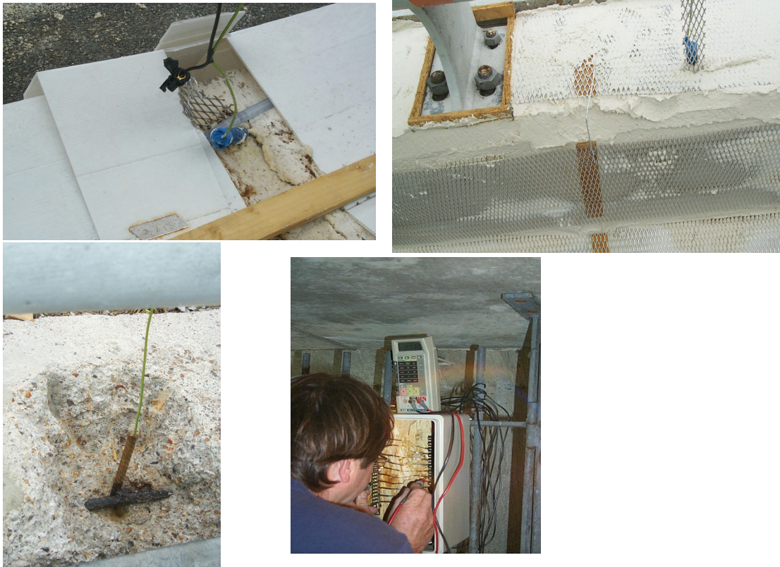
Photo 3 : Illustration du traitement de déchloruration par courant galvanique (crédit photo Freyssinet)
