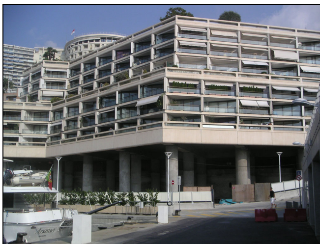
Photographie 1 : Bâtiment Monte Carlo Star reposant sur les piles
