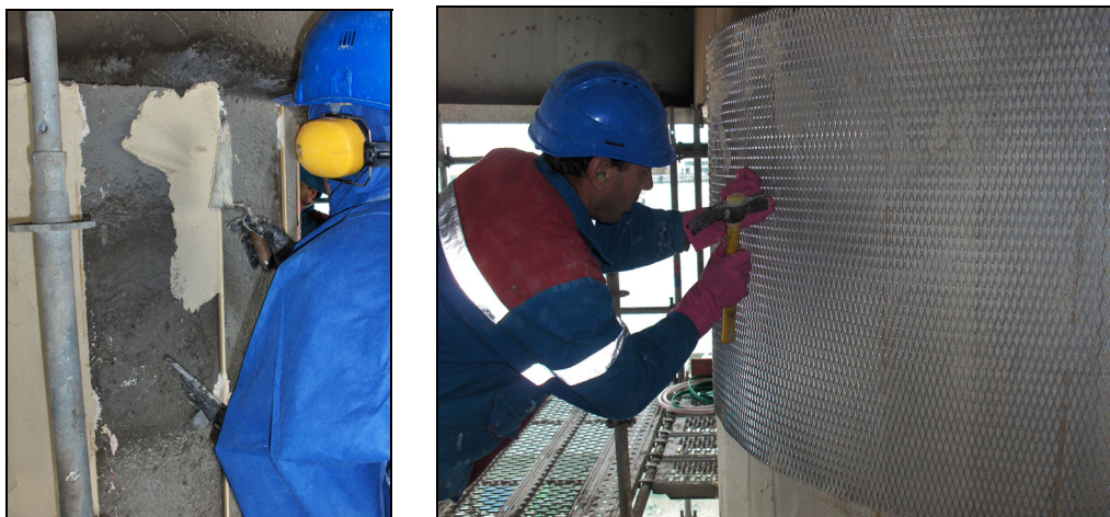
Photographies : application de la pâte Regebeton et du grillage aluminium sur le parement d'une pile
