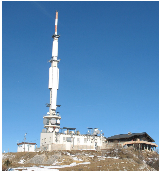
Photo 3 - Vue d'ensemble de la tour
