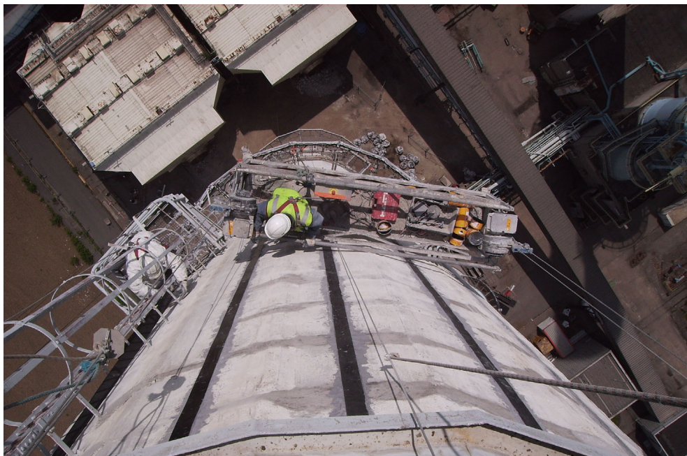
Photo 7 - Tranche 2 : mise en place des lamelles composites depuis les nacelles
