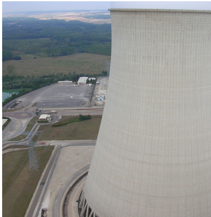
Photo 9 – Réfrigérant atmosphérique de la centrale EDF de Nogent sur Seine
