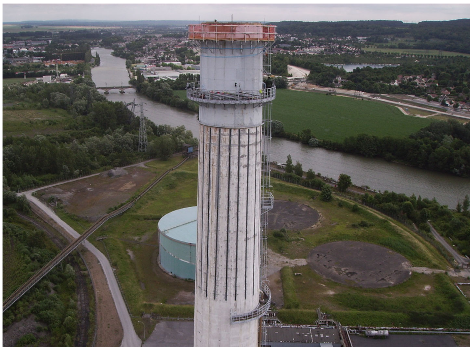
Photo 8 - Vue d'ensemble de la zone renforcée (tranche 2)
