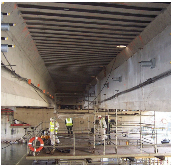
Photo 1 - Renfort composite transversal en intrados du tablier du pont sur l'Huisne
