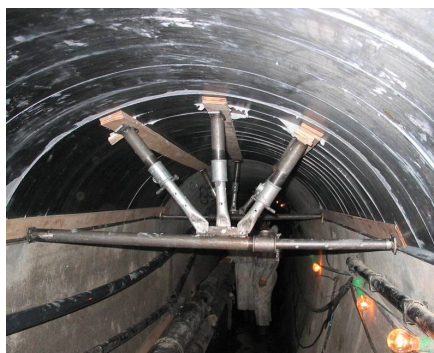
Photo 2 : Placage des lamelles in-situ
