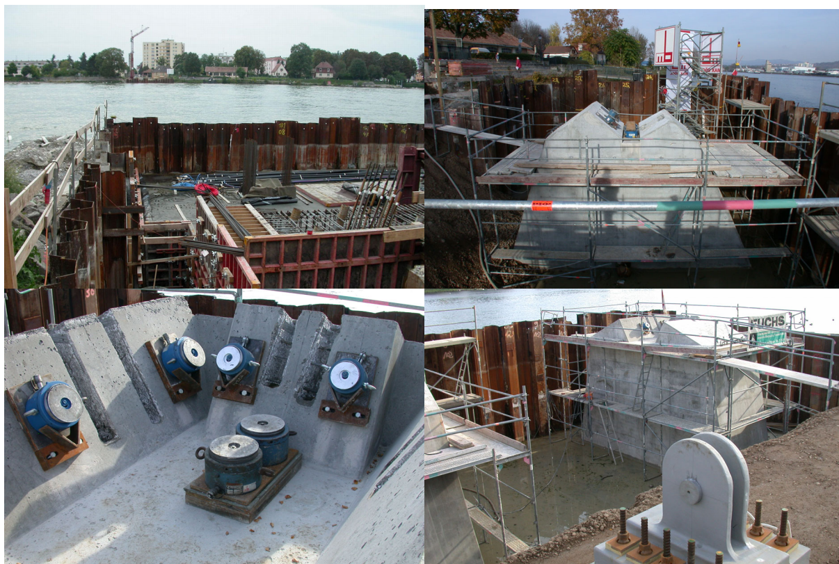
Massifs de fondation, chapes et vérins
