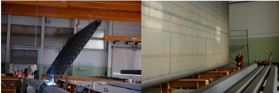
Manutention des éléments en usine
