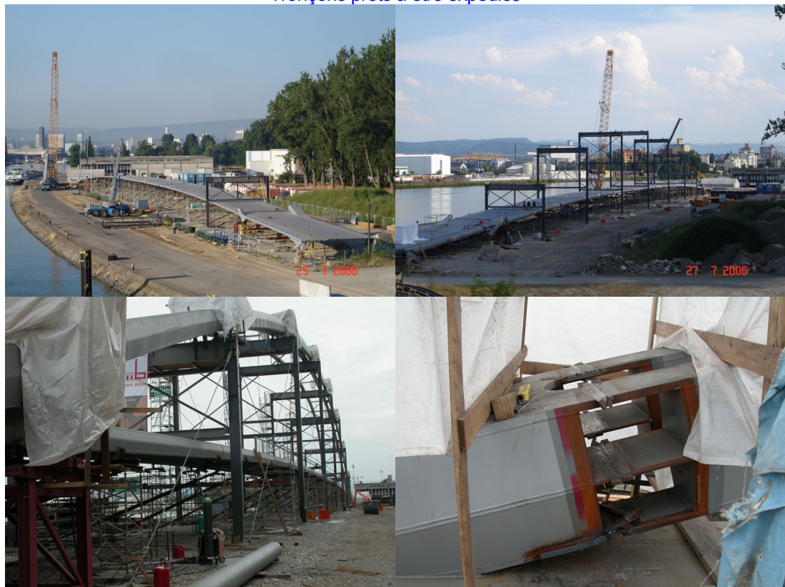
Assemblage des tronçons sur chantier sur échafaudage
