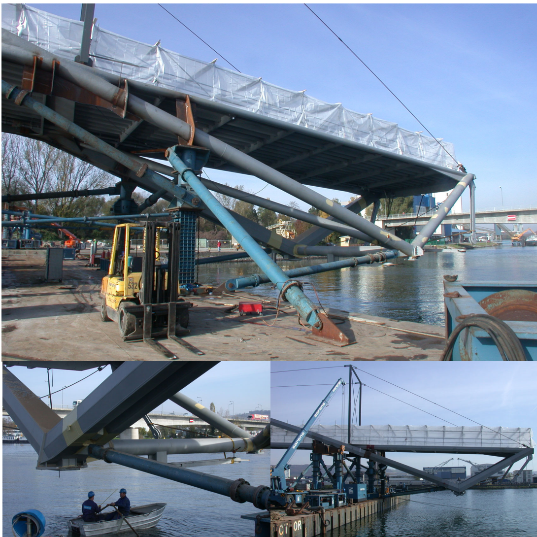
Appuis provisoires et définitifs de la passerelle
