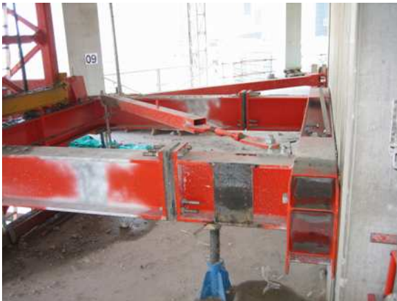
Fixation de la charpente contre le noyau
