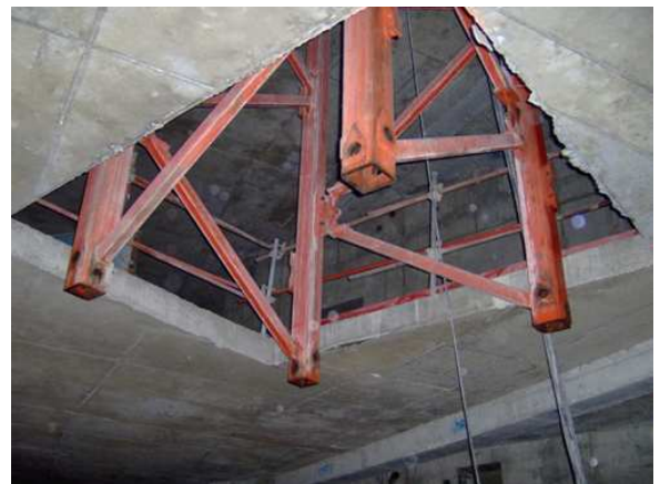
La trémie dans les planchers est rebouchée en sous-œuvre à l'avancement
