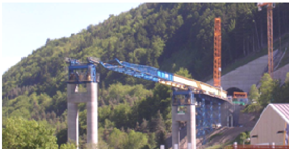
Lançage dans la partie Nord de l'ouvrage
