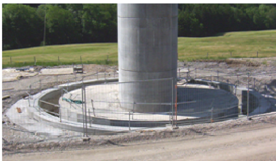
Fondation de la pile P5 une fois terminée
