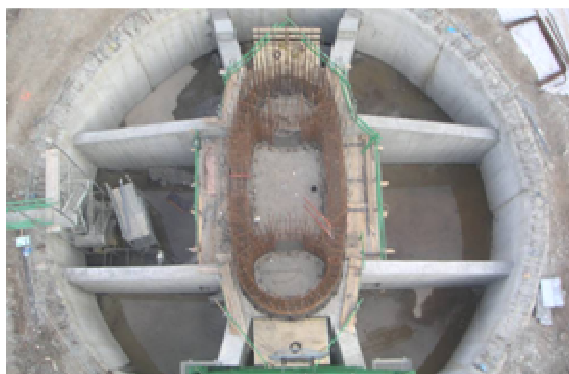
Fondation de la pile P3
