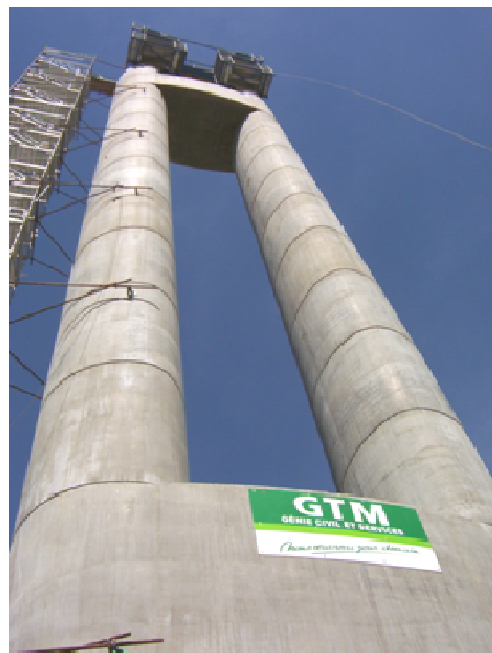
La forme particulière des pilettes crée une fente lumineuse très importante
