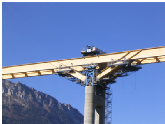
Bracon positionné entre le tablier et la pile
