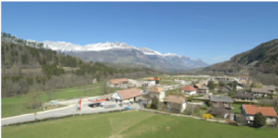
Site avant la construction du viaduc
