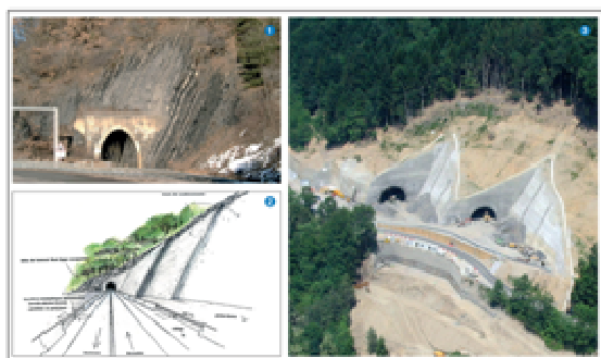
Travail architectural sur les murs en tête Sud du tunnel côté viaduc
