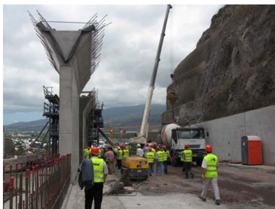
La tranchée couverte de Saint Paul
