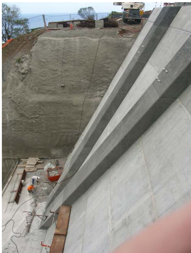
Viaduc de la Ravine Fontaine
