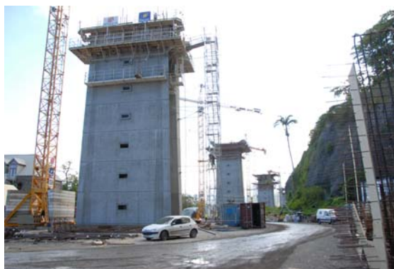
Viaduc de Saint Paul
