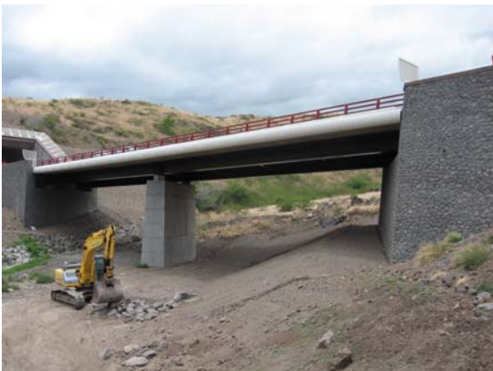
Viaducs de la Savane
