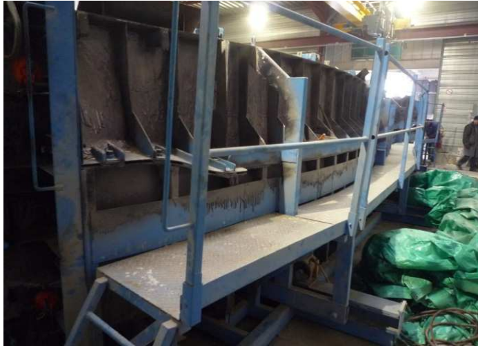
Passerelle d'accès à l'arrière sur un côté
