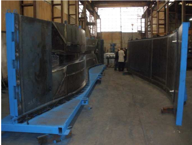
Utilisation d'un coffrage métallique pour 160 réemplois.
