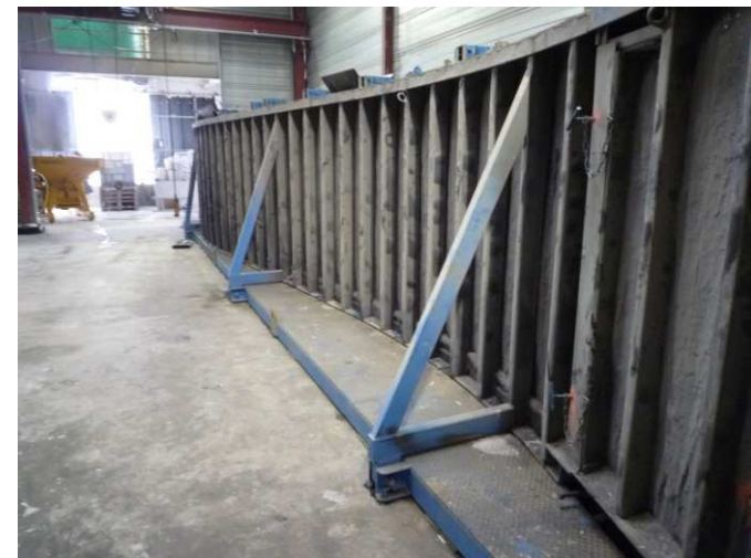
Coffrage auto-stable vertical pour un coulage « à chant »
