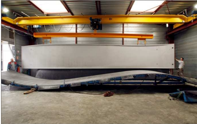
Décoffrage d'une pièce le lendemain du coulage
