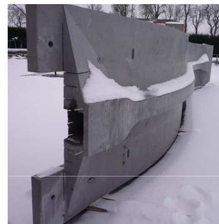
Coque après prélèvement des prismes dans les consoles d'appui
