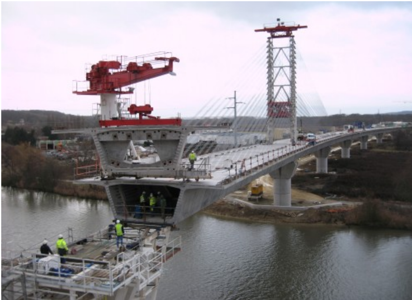
Le viaduc de Compiègne
