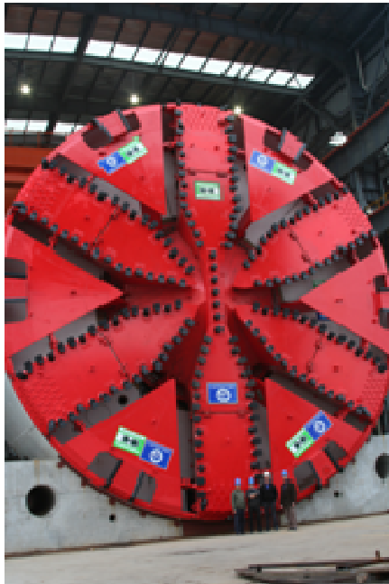
Photo 9 – Tunnel Chong Ming – Bouclier du Tunnelier et Tunnel en construction
