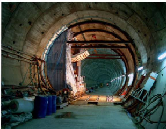
Photo 3 – Tunnel LMC - Préparation de la congélation / preparation for freezing
