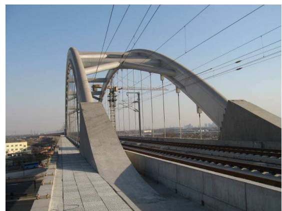
Figure 6 - 4th ring road - arch bridge 60+128+60m 4ème rocade – pont avec arc métallique 60+128+60m
