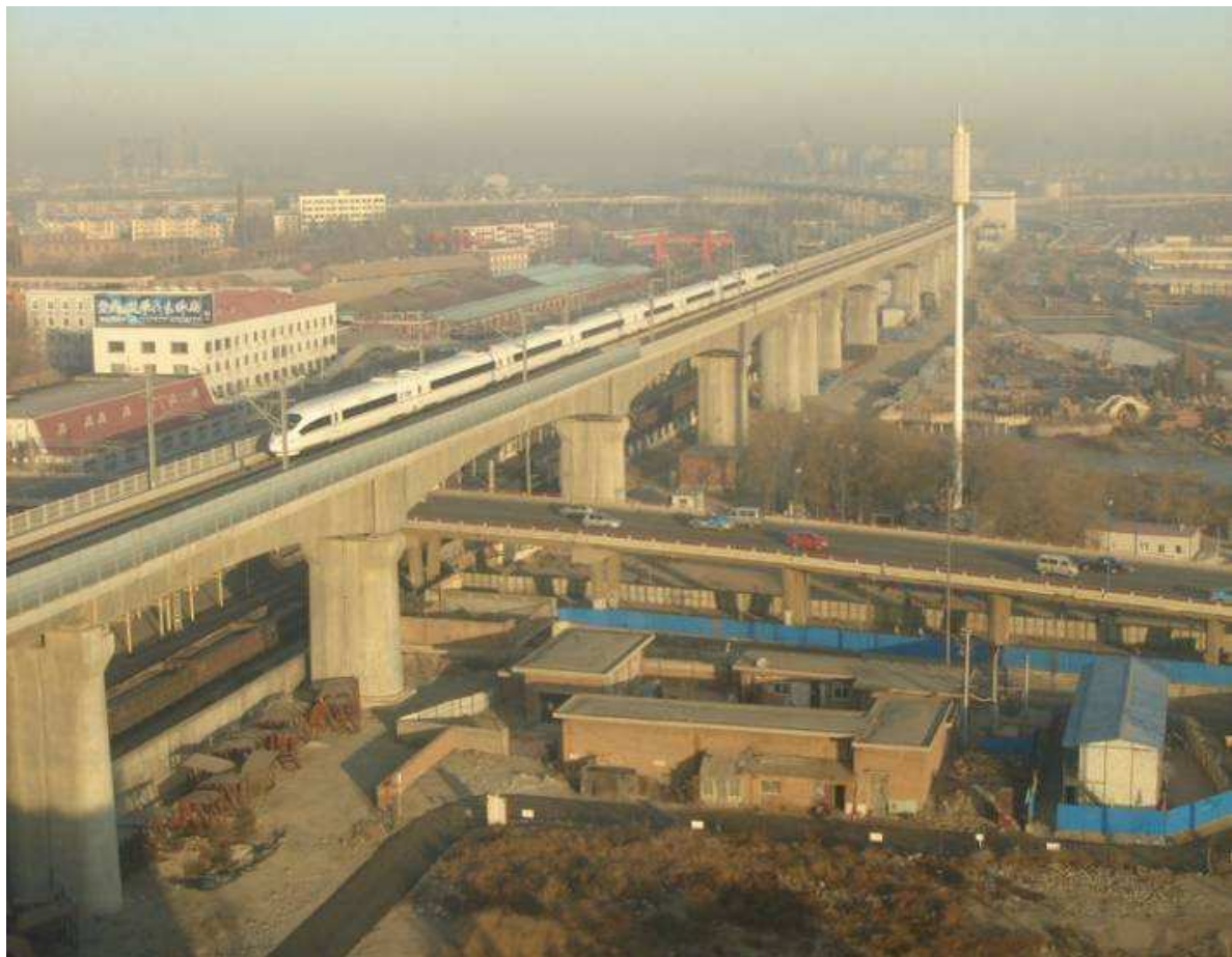
Figure 3 : Train CRH circulant sur le viaduc / CRH train running on the viaduct
