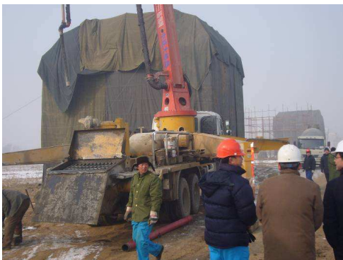
Figure 19 – Pieu coulé à l'abri d'une enceinte chauffée
