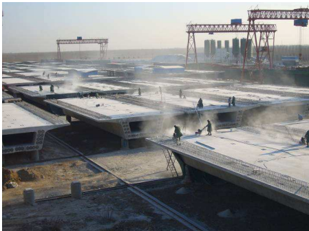
Figure 22 - Polissage des plateformes dans la zone de précontrainte pour obtenir la planéité requise Polishing the decks in the precast yard to reach the deck flatness requirement
