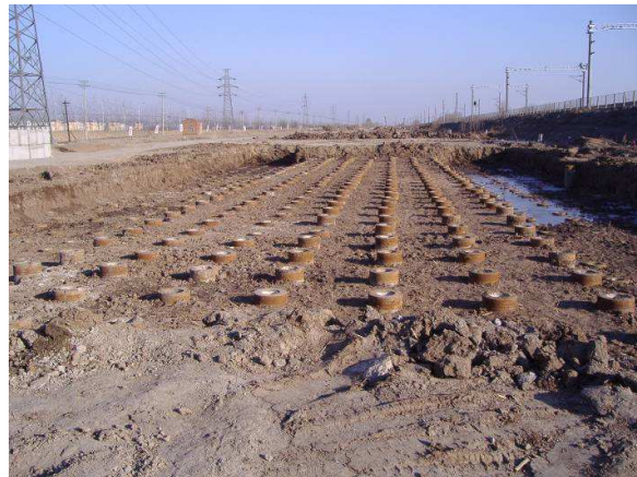
Figure 17 - Piles for the embankment foundation Pieux pour la construction en remblai
