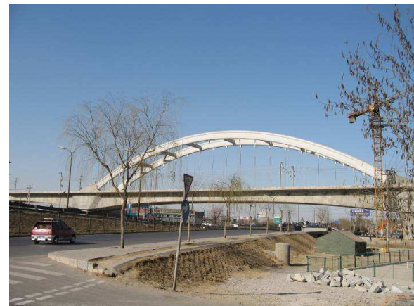
Figure 5 - 4th ring road - arch bridge 60+128+60m 4ème rocade – pont avec arc métallique 60+128+60m
