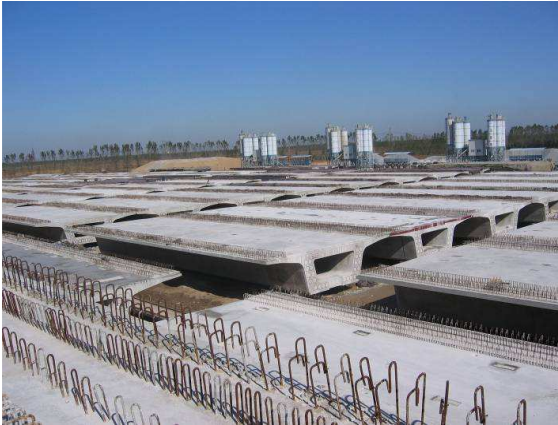
Figure 9 – Aire de préfabrication et de stockage Precast yard
