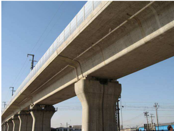
Figure 4 – Vue du pont après achèvement de la ligne View of the bridge after completion of the line
