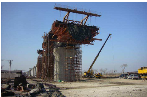
Figure 21 - Segments of cantilever bridges cast under heated enclosure Coulage de voussoirs du pont en encorbellements sous enceinte chauffée
