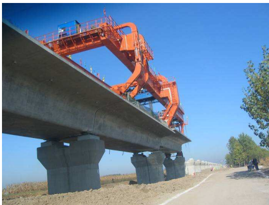
Figure 12 – Poutre de lancement
