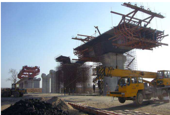
Figure 14 – Pont à encorbellements successifs en construction Cantilever bridge under construction
