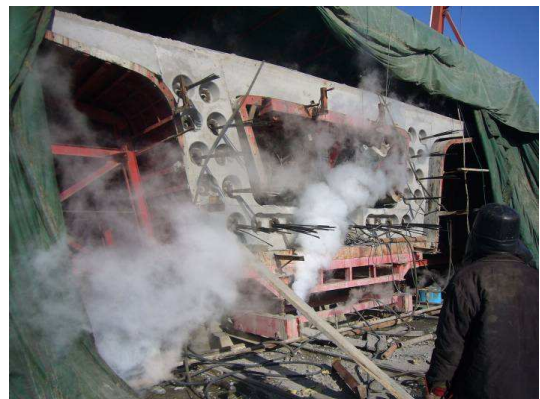
Figure 18 – Steam curing in the precast yard Etuvage sur la zone de préfabrication
