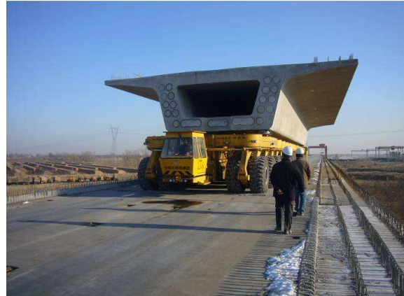
Figure 11 – Trucking of precast unit Transport de l'élément préfabriqué
