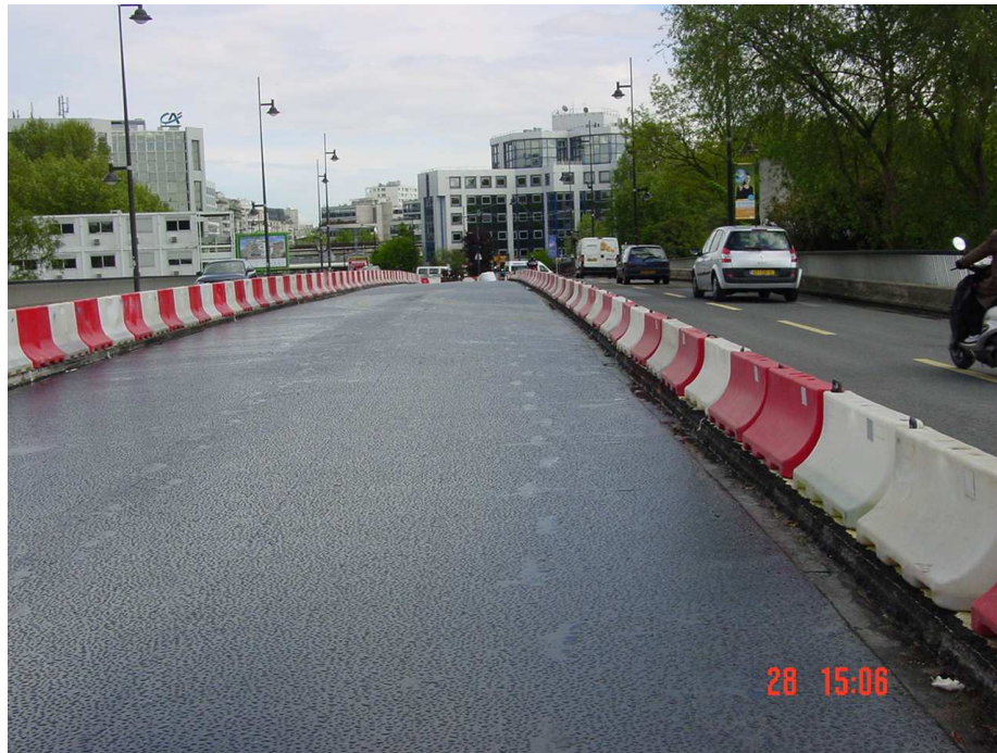
Photo 9 : Réfection de l'étanchéité en partie centrale ; la circulation automobile est maintenue sur 2 x 2 voies de part et d'autre de la zone travaux Rehabilitation of the waterproofing in middle section, with traffic maintained in 2 x 2 lanes on either side of works area
