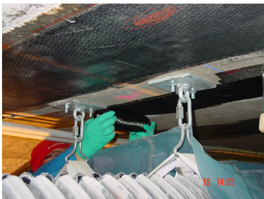
Photo 22: L'implantation des bandes de TFC a été adaptée sur site en fonction des contraintes dues aux supports de ligne HT Laying of TFC® strips had to be adapted to the presence of HV line supports.
