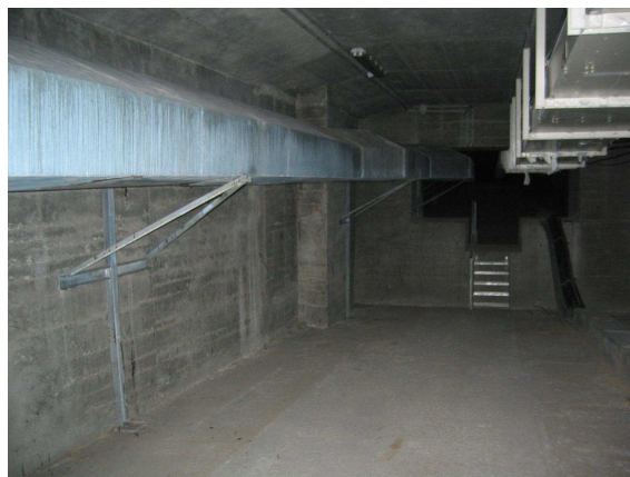
Photo 3b : Réseaux concessionnaires dans le caisson aval avant travaux (à gauche CPCU, à droite RTE, ligne HT 225kV)
