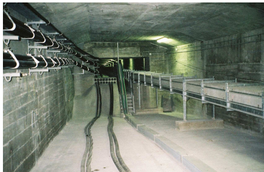
Photo 3 : Réseaux concessionnaires dans le caisson amont avant travaux (à gauche ligne HT 63 kV, à droite batterie de fourreaux FT)
