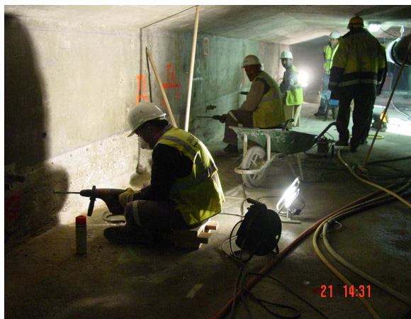
Photo 6 : Forage du caisson en vue du scellement des armatures HA du gousset central à créer Drilling of box girder in order to grout the HB reinforcements in the future central fillet.
