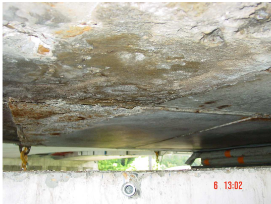
Photo 25 : Après dégagement de l'ancien appareil d'appui, en fonction de la qualité de surface de l'intrados, on juge l'opportunité de la mise en place d'une plaque d'acier scellée à la résine ; ici la plaque d'acier sera mise en place. After removing the old bearing, the state of repair of the soffit surface was examined to determine whether or not the resin-grouted steel plate used here, for example, was necessary.
