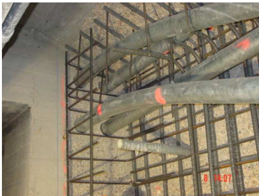
Photo 20 : Forages de diamètre 162mm, de longueur 1.60m dans les entretoises sur piles en vue du passage des 4 câbles 19T15S à ancrer dans un massif B3 situé derrière l'entretoise.. 1.60 m long, 162 mm diameter holes drilled in the pier diaphragms to take four 19T15S cables to be anchored in block B3 behind the diaphragm.
