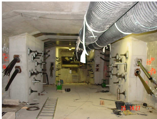
Photo 18 : Caisson amont, vue d'ensemble bossages B3 et B4 : les sur-longueurs des barres et des câbles protégés à la cire pétrolière permettent leur remise en tension ou leur démontage éventuel si nécessaire. Upstream box girder, overall view of blisters B3 and B4: the extra length of the reinforcements and protection of the cables with petroleum wax are designed for re-tensioning and dismantling if necessary.
