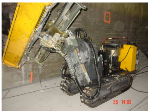
Photo 14 : Hydrodécapage des surfaces béton réalisé à 2000 bars de pression et commandé à distance. La démontrabilité de l'outil a permis de l'introduire dans les caissons par un trou d'homme de 1.20m x 0.80 m.
