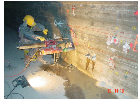
Photo 11 : Caisson amont : forage de l'âme par carottier de diamètre 72 mm en cours d'exécution Upstream girder: drilling of web with 72 mm diameter corer during works
