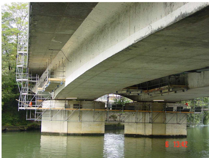
Photo 2 : Piles Petit Bras (photo prise depuis RG aval) / Petit Bras piers (photo taken upstream from east bank)
