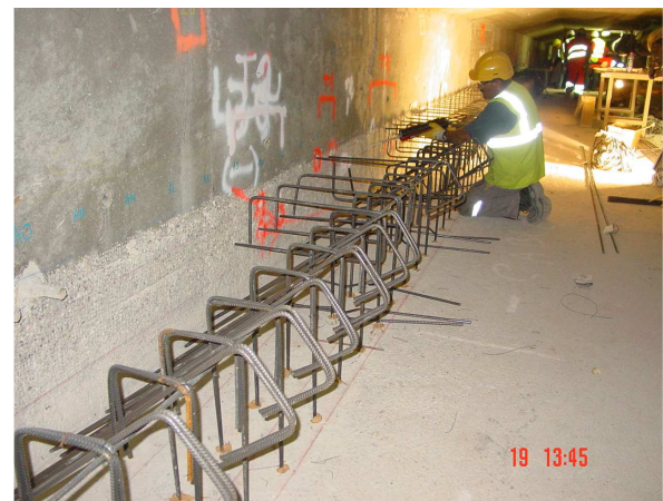
Photo 7: Grouting of reinforced concrete fillet reinforcements at mid-span Scellement des armatures du gousset en béton armé à mi-travée centrale
