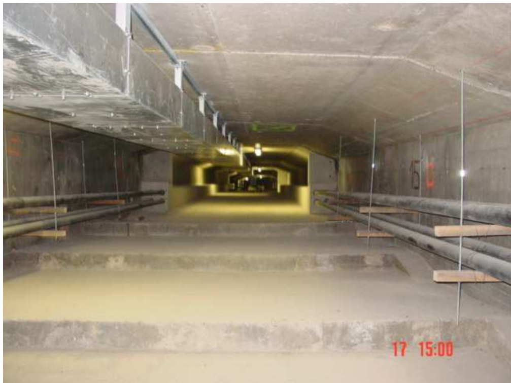
Photo 8 : Vue générale caisson aval après travaux, en arrière plan on aperçoit le gousset central et les déviateurs à ses extrémités Overall view of downstream girder after rehabilitation, showing central fillet in background and deviators at both ends
