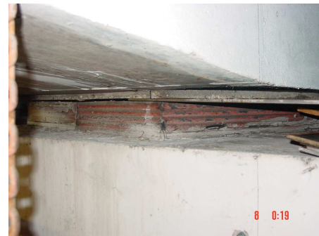
Photo 24: Insertion of metal shims in order to raise the deck Interposition de cales métalliques en vue d'assurer le levage du tablier
