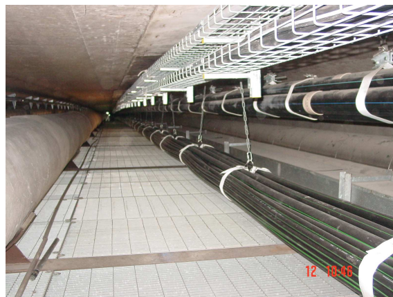
Photo 5 : The area between the girders before the utilities were moved / L'espace entre caissons après travaux de déplacement des réseaux
