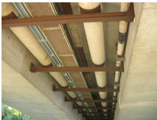
Photo 4 : Réseaux concessionnaires entre les 2 caissons avant les travaux (on aperçoit notamment 2 tuyaux Ø800 CGE et une conduite de gaz à droite)
