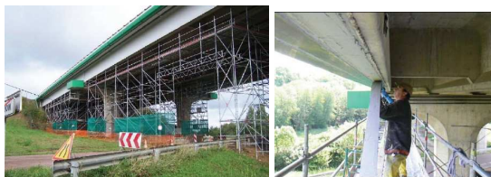
Fig. 12. Renforcement du pont de Toutry
