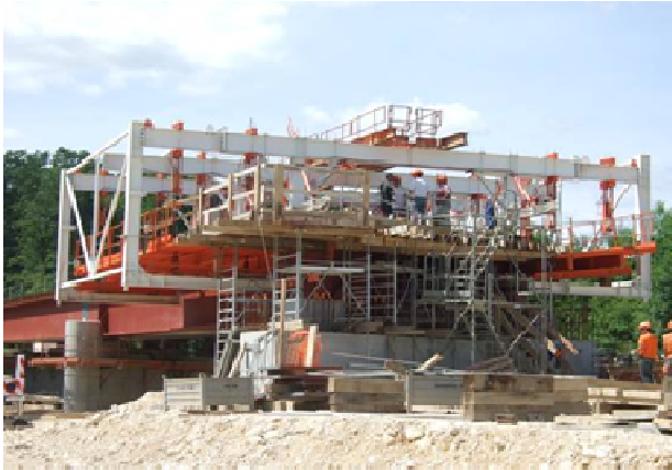
Coffrage mobile pour réaliser le hourdis béton
