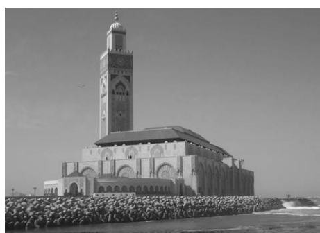
Figure 8 : digue de protection périphérique recouverte de tétrapodes
