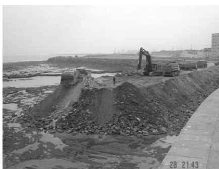
Figure 7 : construction de la digue de protection périphérique
