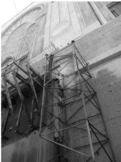
Figure 15: mise en place d'un voile de protection périphérique en BHP armé d'armatures inox (à noter les toiles de jute arrosées pour prolonger la cure des bétons)
