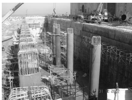
Figure 17: reconstruction des peignes brisés houle en BHP armés d'armatures inox (à noter les toiles de jute arrosées pour prolonger la cure des bétons)
