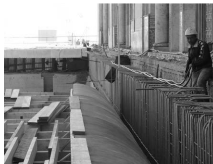
Figure 18 : reconstruction de la dalle des pompiers en BHP armé d'armatures inox
