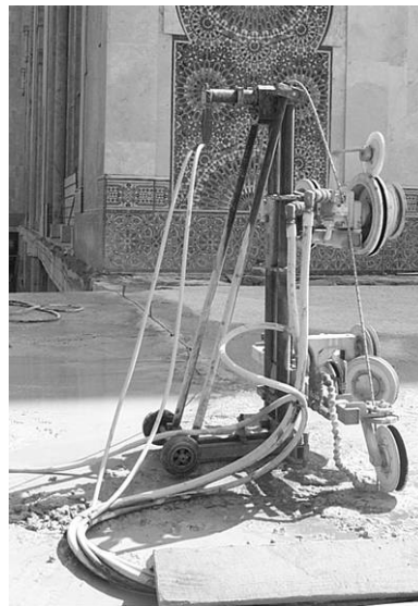
Figure 16 : fil diamanté utilisé pour la découpe de la dalle des pompiers et le tronçonnage des poteaux des peignes brises houle
