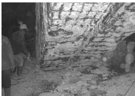
Figure 9 : décroûtage des bétons dégradés par la corrosion
