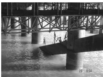
Figure 2 : vue générale sous la dalle des pompiers, supportée par les peignes brises houle
