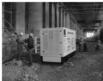
Figure 10 : poste d'hydro-démolition (sous dalle des pompiers)
