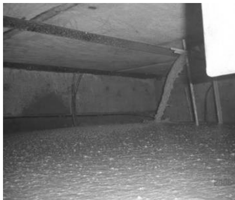
Figure 13 : mise en place d'un béton auto-plaçant de confinement avant clavage au coulis
