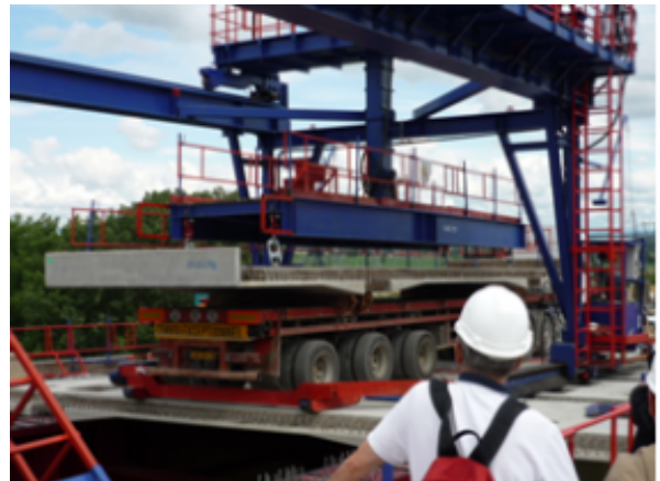
Le portique de pose et l'acheminement de la dalle par camion
