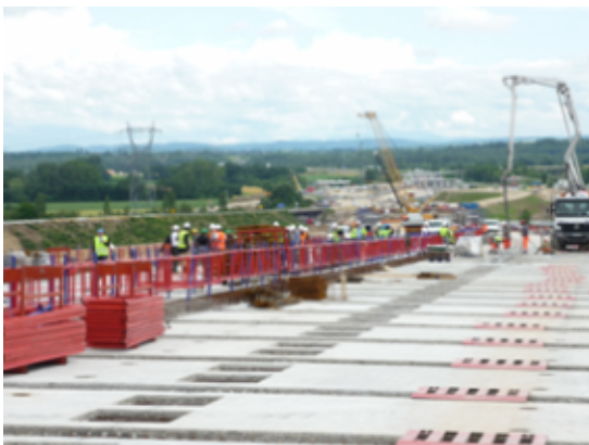
La visite du chantier
