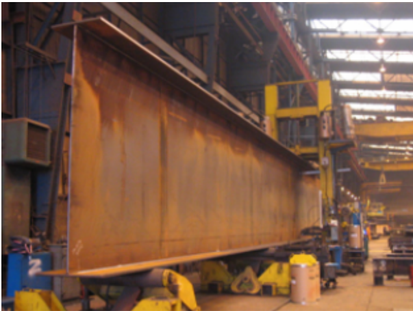
Fabrication à l'usine de Lauterbourg (Eiffel) des poutres métalliques
