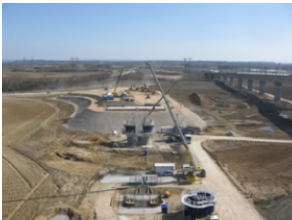
La construction du remblai culée Sud-Est
