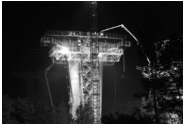
Le bétonnage de nuit
