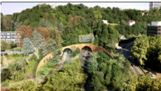
Entrée du tunnel côté Saône
