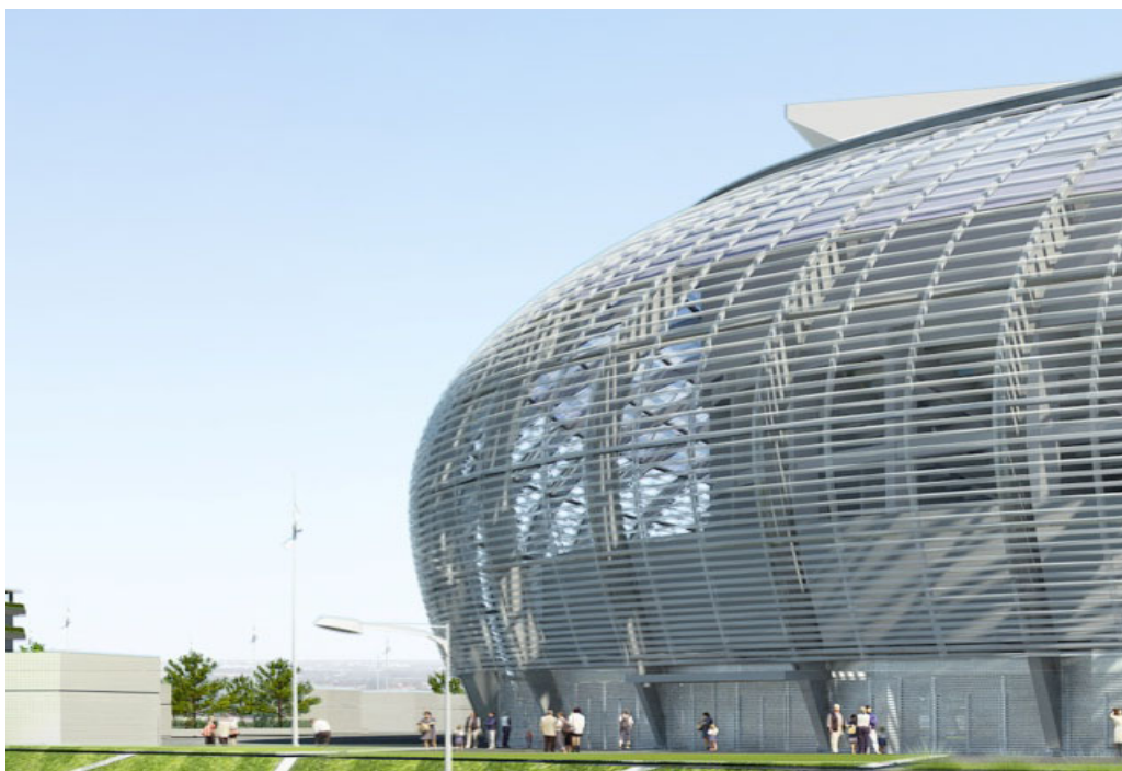
Structure métallique extérieure
