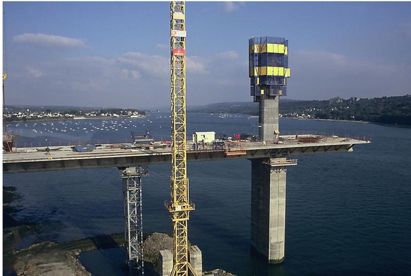
Démarrage de la construction du pylône rive droite en coffrage auto-grimpant
