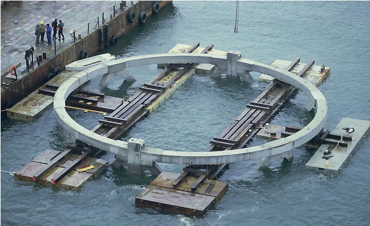
Cadre du batardeau circulaire, en béton, préfabriqué en deux parties pour permettre son démontage et son transfert d'une pile à la suivante
