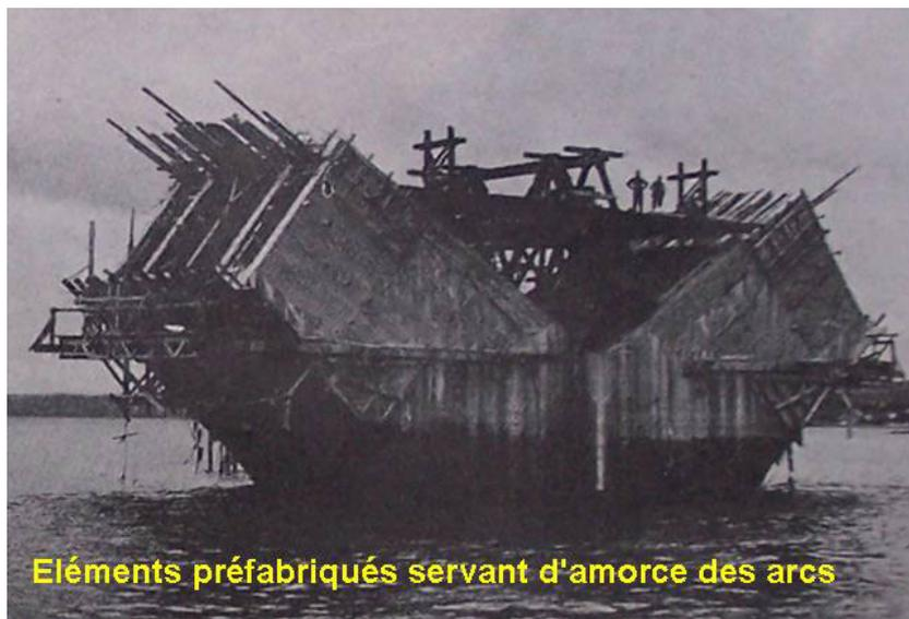
Construits en encorbellement, maintenus et réglés par des tirants horizontaux
