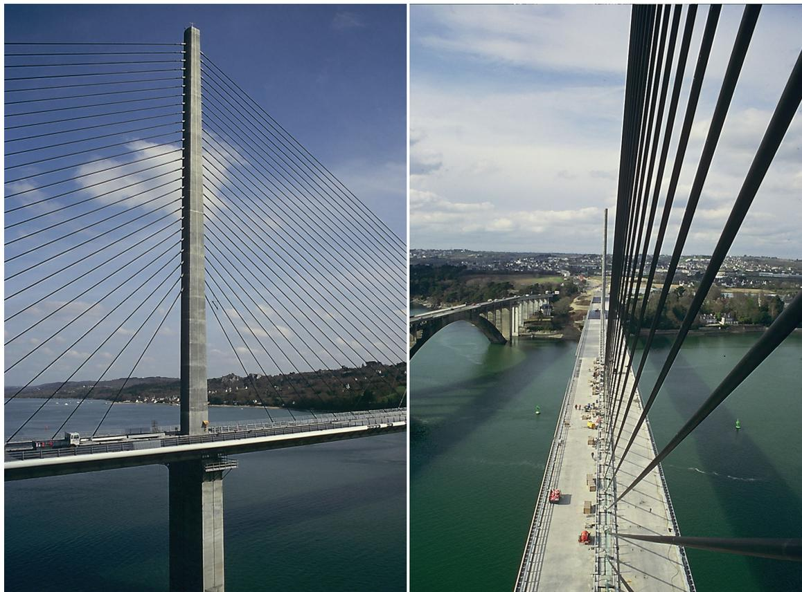
Ici toute la pureté et la finesse du haubannage axial ..... et fin du second fléau en rive gauche de l'Elorn et clavage (avec moins de 9 mm d'écart en altitude entre les deux fléaux)
