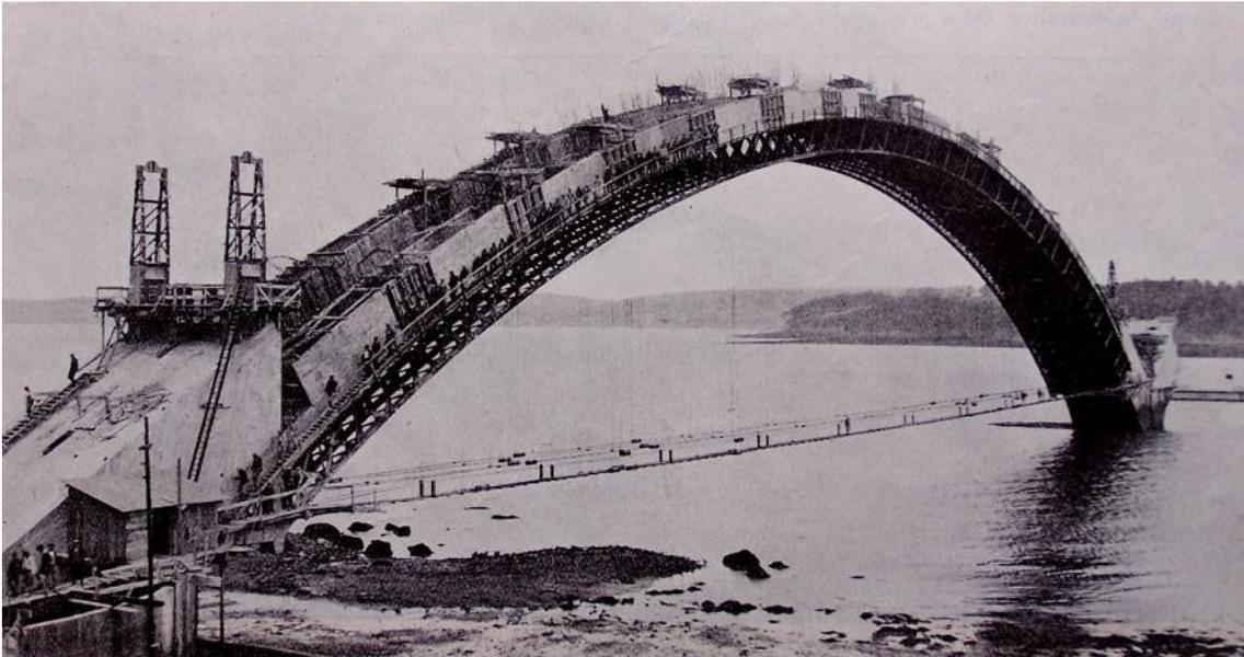
L'arc se décompose en 7 éléments principaux, chaque élément étant lui même coulé en 6 phases.
