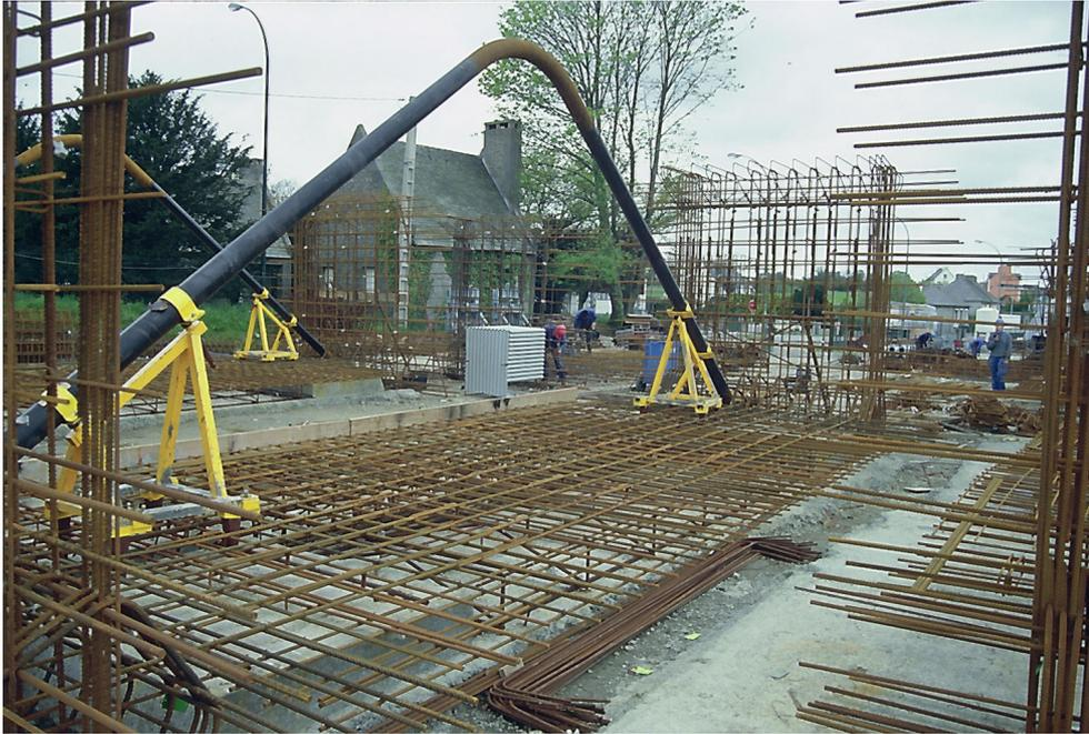
Préfabrication des cages d'armatures des voussoirs ou des plots incluant le tirant intérieur métallique
