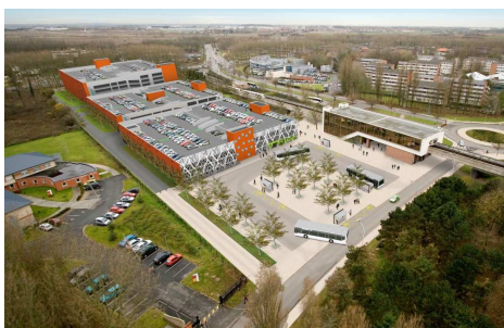
Autour de la station 4 Cantons : Parking P+R, gare bus et parvis
