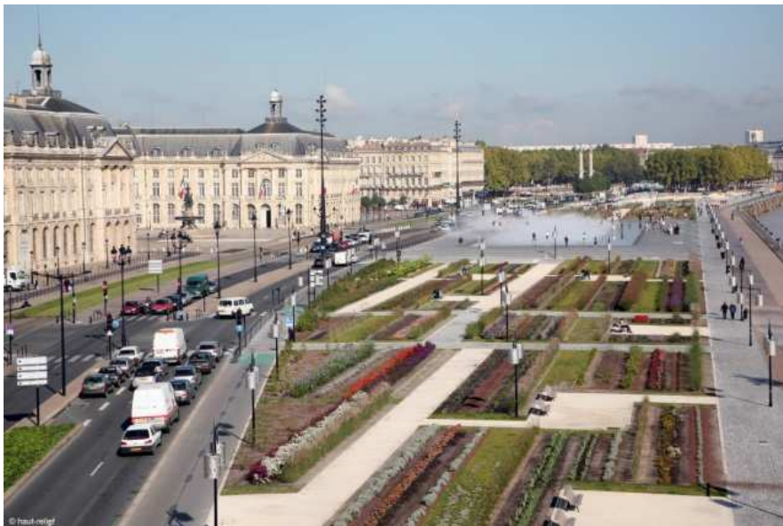
Aménagement des quais
