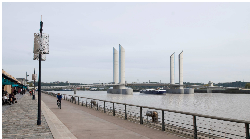
433m de long Tirant d'air du Pont de pierre en position basse
