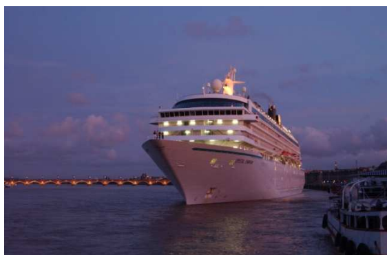
Un pont permettant l'accueil des grands navires
