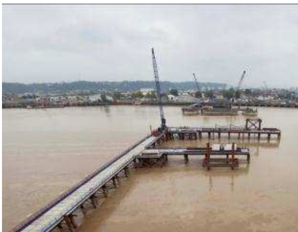
Batardeau Pile P1
