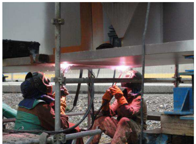
Soudure entre de deux tronçons de poutre
