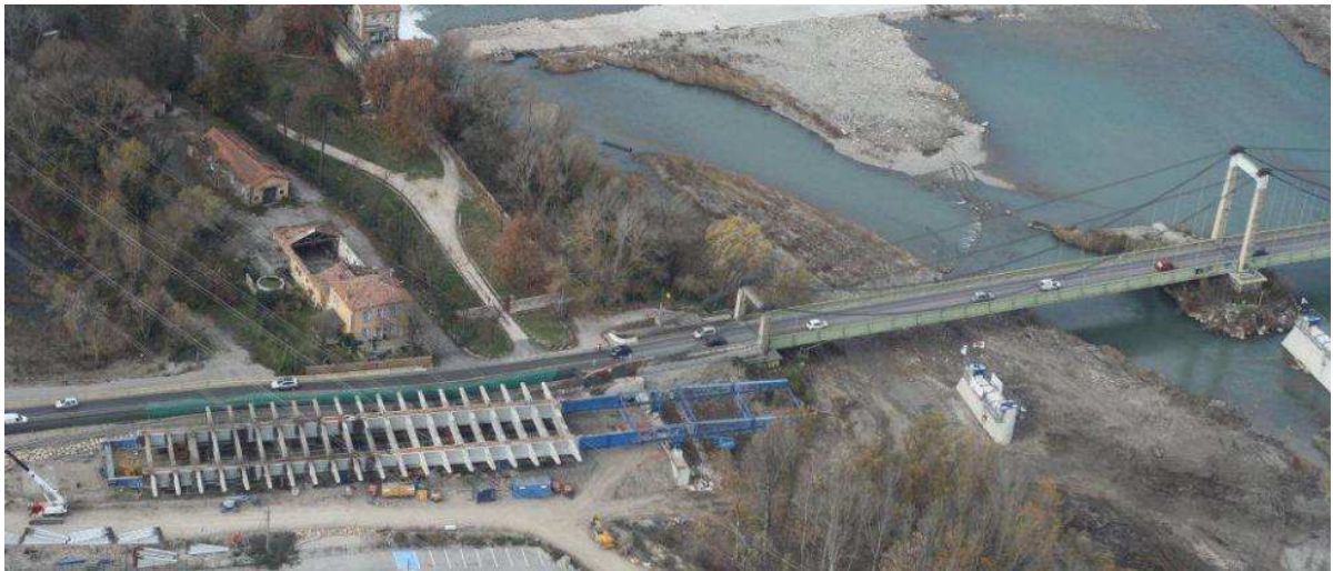
Vue aérienne du pont existant et du futur nouveau pont de Pertuis
