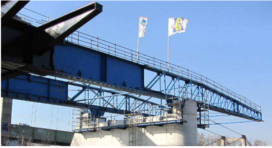
Piles munis de ses équipements
