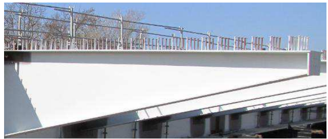
Vue des goujons présents sur la charpente
