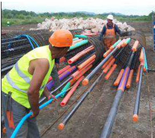
Installation des gaines PVC sur les armatures
