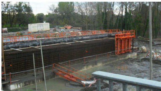
Montée des eaux au niveau de la culée C4
