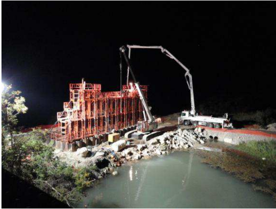
Coulage de nuit d'une pile
