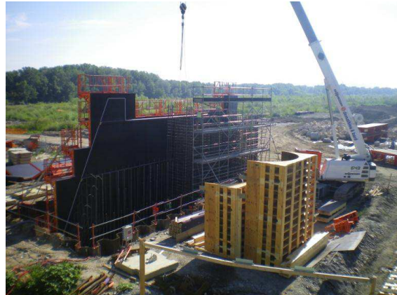
Coffrage des piles
