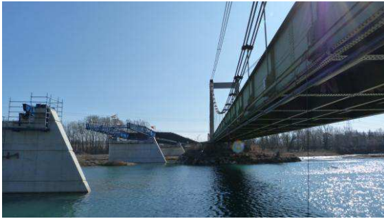
Espace entre les deux ouvrages
