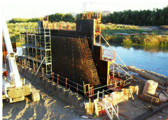
Ferrailage des piles mis en place
