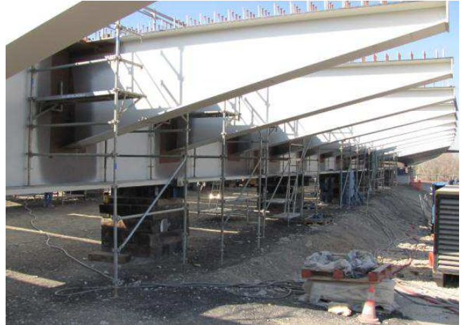
Assemblage des pièces de pont au niveau de CO
