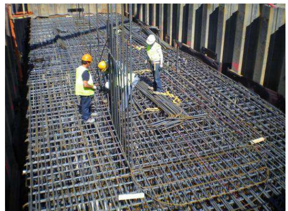
Aciers en attente pour l'élévation
