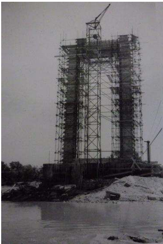
Photo prise en 1952 de la construction du pont
