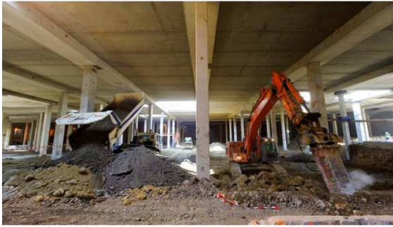
Figure 18 : Phase 2: Terrassement en taupé
