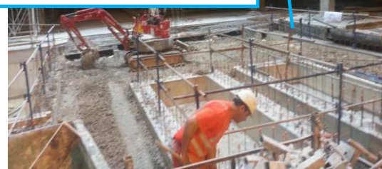
Figure 39 : Le vide sanitaire et les longrines
