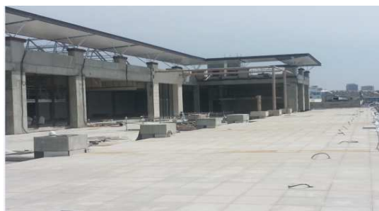
Figure 40 : La terrasse panoramique
