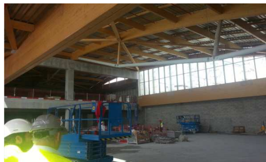
Figure 46 : Espace pour les Printemps avec une charpente design et aux normes sismiques
