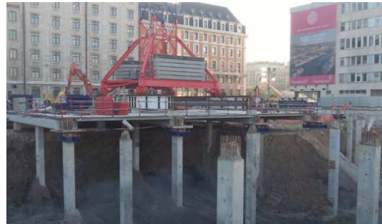
Figure 34 : Stabilité des planchers et des préfondés sous la charge des grues
