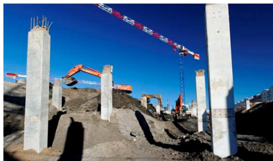
Figure 17 : Phase 1 : Terrassement à ciel ouvert
