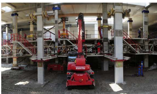
Figure 25 : Coffrage des planchers d'infra
