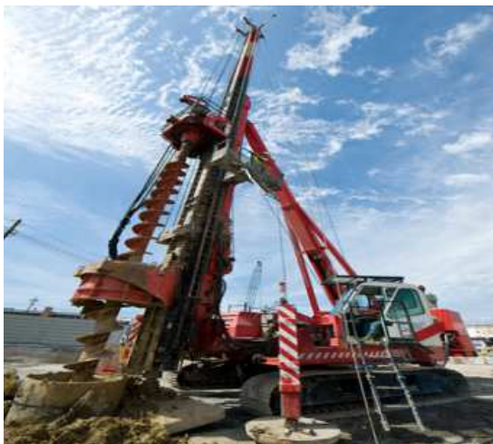
Figure 20 : Forage pour préfondés
