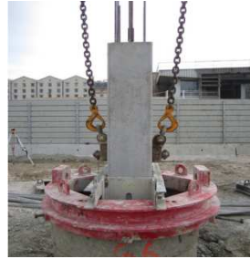
Figure 21 : Pose des préfondés
