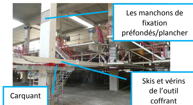
Figure 27 : Outil coffrant du plancher
