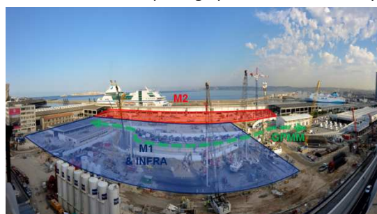
Figure 14: Découpage chantier en Juillet 2011
