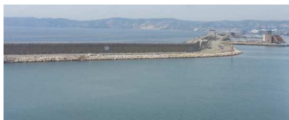
Figure 47 : Vue panoramique depuis la terrasse avec la digue
