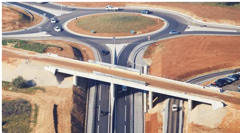
PRA 5 travées au dessus de la RN113
