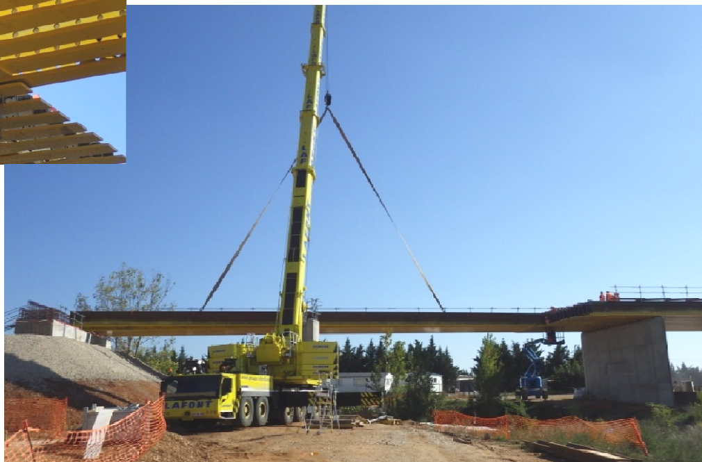
Mise en place des poutrelles à la grue, souvent sous coupure routière ou ferroviaire
