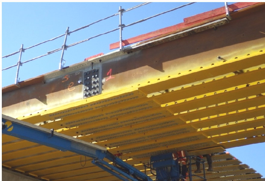
Eclissage boulonné des poutrelles en cours
