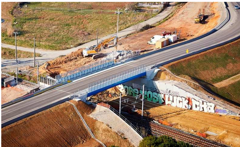
TPE PRO au-dessus de la voie ferrée existante Montpellier-Perpignan (rétablissement en service)
