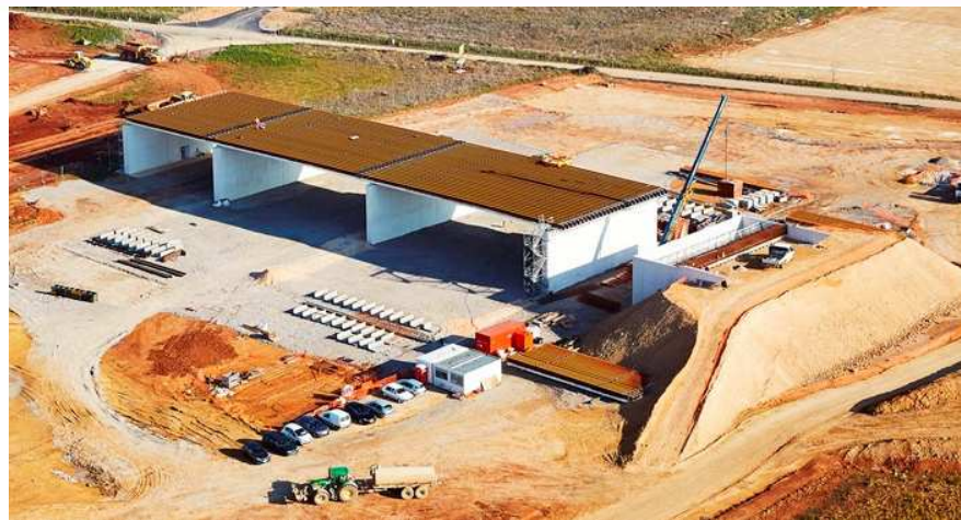
TPE PRO au-dessus de la future Gare TGV « Montpellier - Sud de France »
