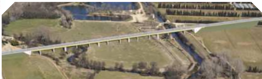
Viaduc du Vistre
