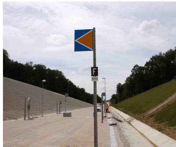
Pose de poteaux bétons
