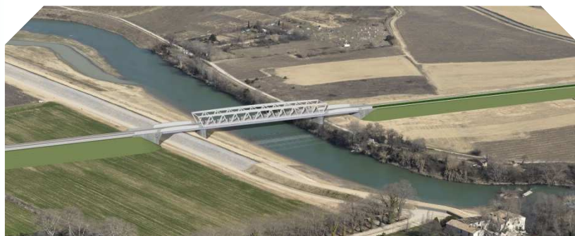
Viaduc du Vidourle
