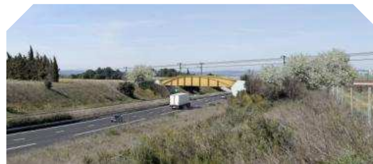
Viaduc de l'A54
