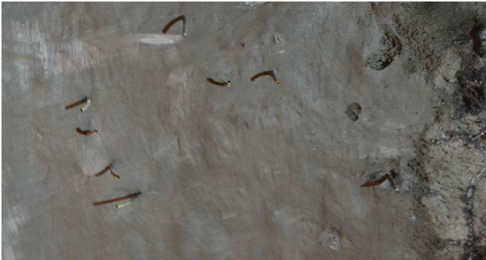
Fig. 5. Drains de décharge et mortier de régularisation et d'étanchement temporaire
