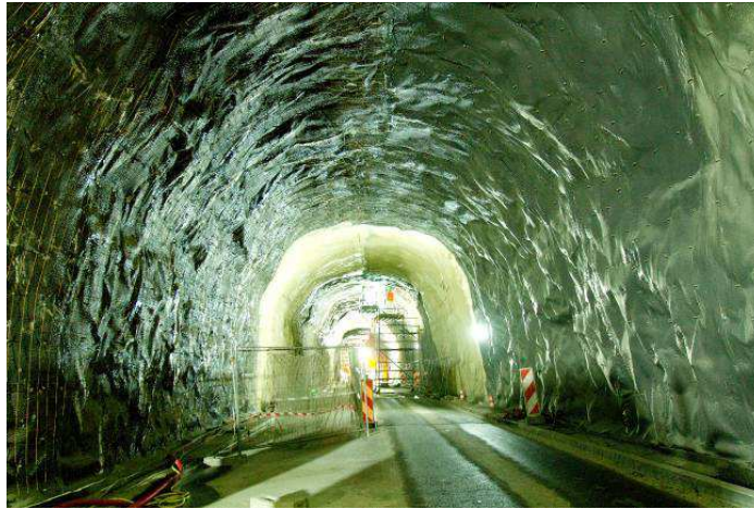
Fig.9. Coque PROTHEANE AC/TI en cours de ferrailage, avant projection du béton
