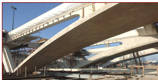
Fig. 5. Squelette de la structure sur chantier / Structural skeleton on site
