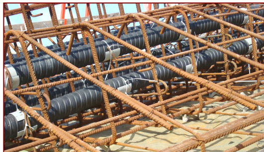
Fig. 21. Protection des gaines PEHD / HDPE sheath protection
