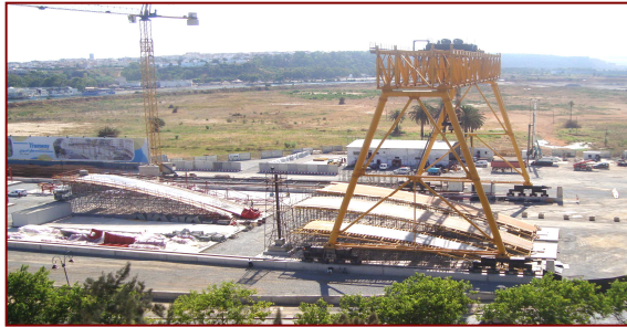
Fig. 25. Portique sur l'aire de préfabrication / Gantry on precasting yard
