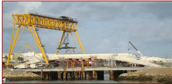
Fig. 25. Portique sur le pont provisoire / Gantry on temporary bridge
