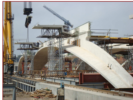
Fig. 13. Parements préfabriqués des nœuds centraux / Precast facings of central nodes
