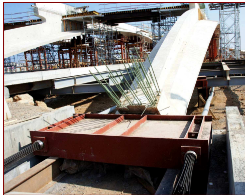
Fig. 26. Bâti d'ancrage des tirants d'une palme / Frame for anchoring palm tie
