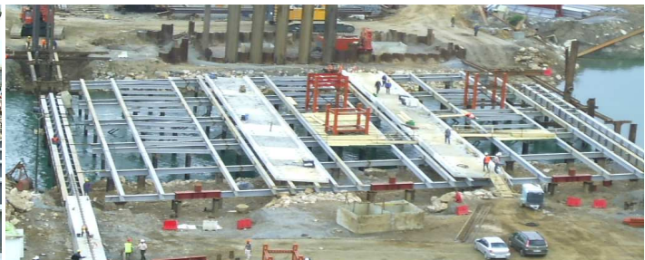
Fig. 24. Pont provisoire : construction avancée / Temporary bridge: well on construction
