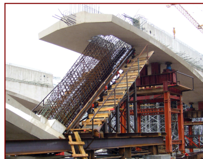
Fig. 8. Ferrailage d'une béquille / Slant-leg reinforcement
