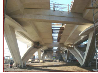
Fig. 11. Les entretoises / Cross beams
