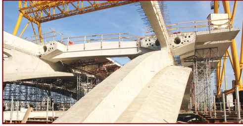
Fig. 9. Une entretoise liant 2 nœuds / 2 nodes linked by a cross beam
