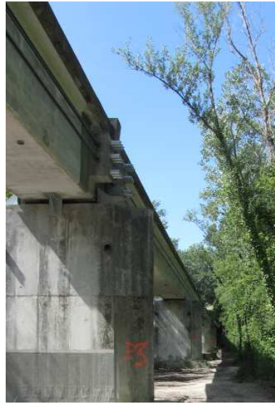
Figure 9 : Vue de l'ouvrage après réparation / View of the structure after repair
