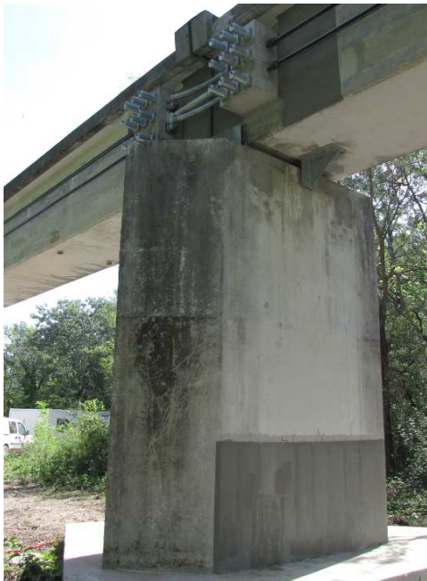
Figure 8 : Confortement des embases de piles par composites / Reinforcement of the piles bases by composites
