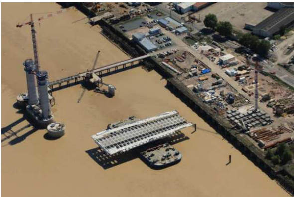
Pose des travées d'accès rive droite en août 2011
