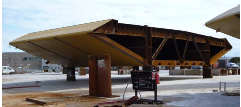
Tronçon de caisson de la travée levante en cours de fabrication
