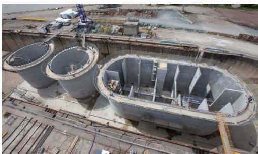
Les caissons béton en cours de construction dans la cale sèche / Le convoyage d'un îlot sous le pont d'Aquitaine
