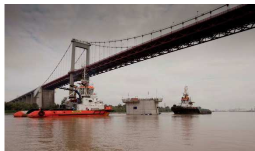
Les caissons béton en cours de construction dans la cale sèche / Le convoyage d'un îlot sous le pont d'Aquitaine
