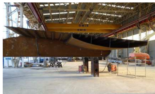
Les travaux de charpente en atelier : caisson principal de la travée levante et consoles support des passerelles
