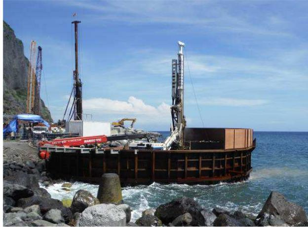
Figure 5 : Mise en place d'une hauteur de virole de la pile P2
