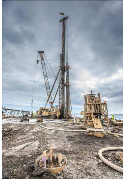
Figure 7 : Réalisation des pieux des culées selon la méthode du marteau fond de trou
