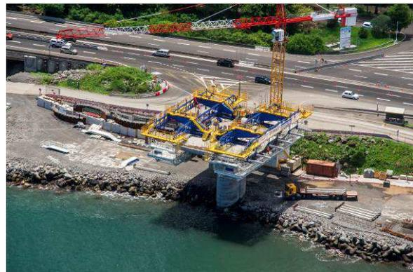
Figure 9 : Ames préfabriquées réalisées sur l'aire dédiée      Figure 10 : Fléau de la pile P2 en cours de réalisation
