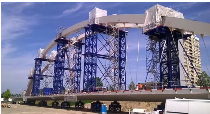
Figure 13 – Palées d'appui et de montage des arcs
