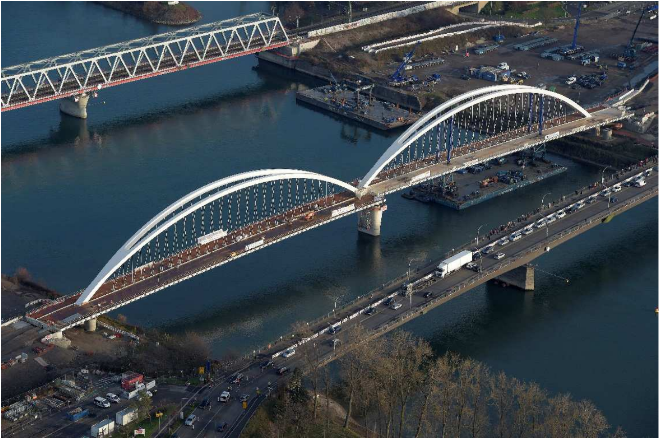
Figure 15 - Vue aérienne de la mise en place des tabliers © @airdiasol-Rothan
