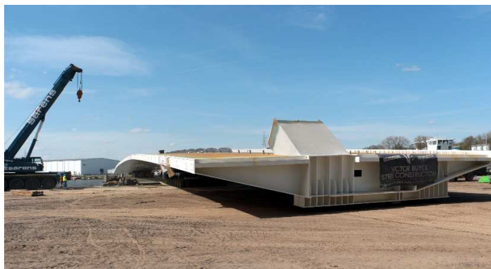
Figure 11- Chargement des tabliers à Gand
