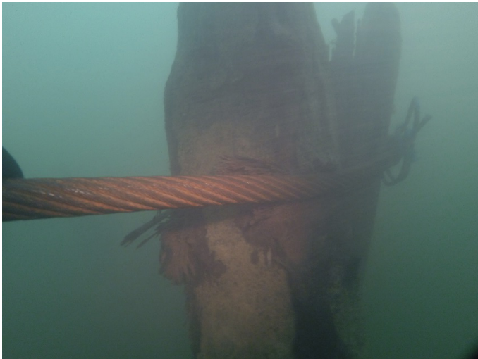
Figure 14 - Pieux en bois au fond du Rhin
