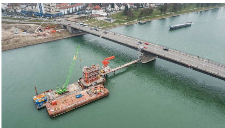
Figure 8 - Estacade provisoire, mât de bétonnage et barge
