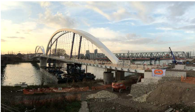
Figure 1 – Vue d'ensemble du pont depuis la berge allemande
