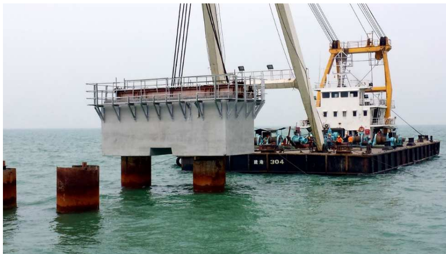
Fig.6. Coque préfabriquée de semelle. ©photothèque BYTP
