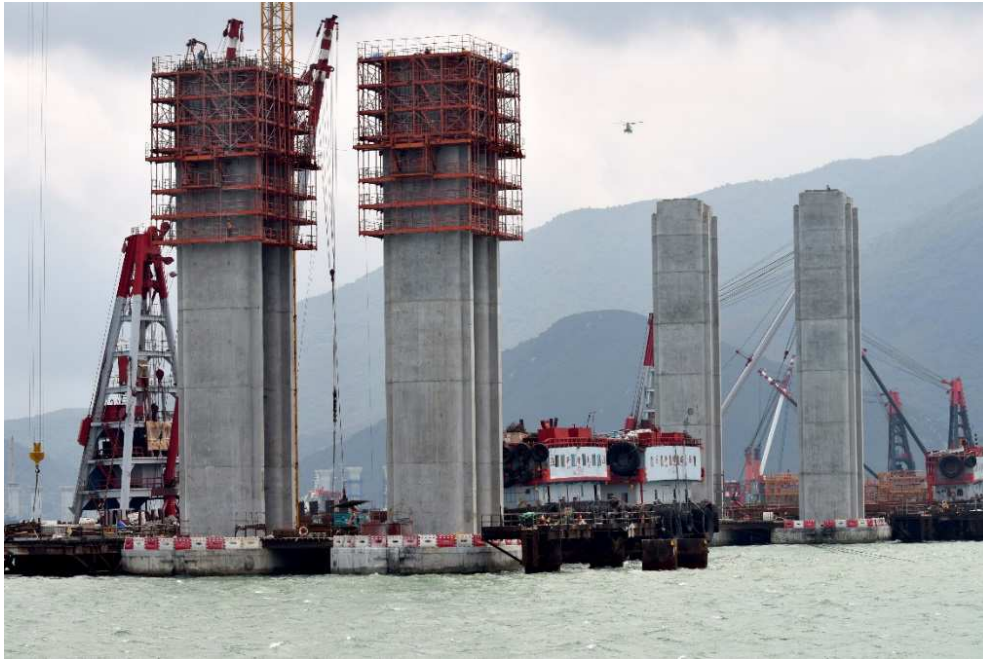
Fig.9. Piles des grands viaducs. ©photothèque BYTP
