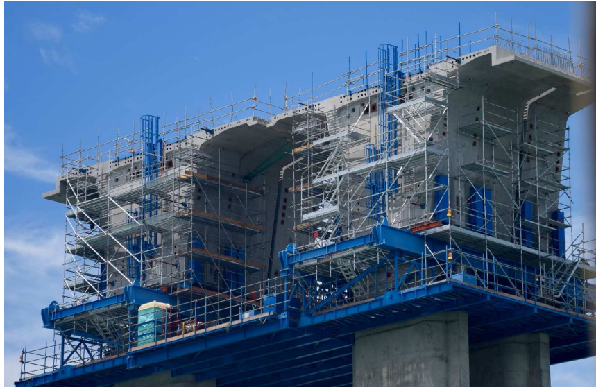
Fig.12. VSP des grands viaducs. ©photothèque BYTP
