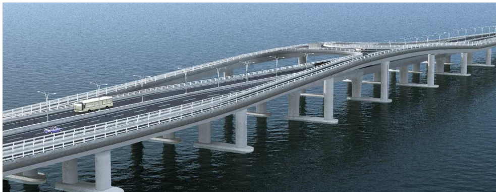
Fig.4. Ouvrage de Retournement. ©photothèque BYTP
