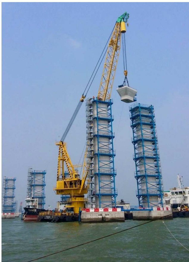
Fig.7. Piles préfabriquées des viaducs maritimes ©photothèque BYTP
