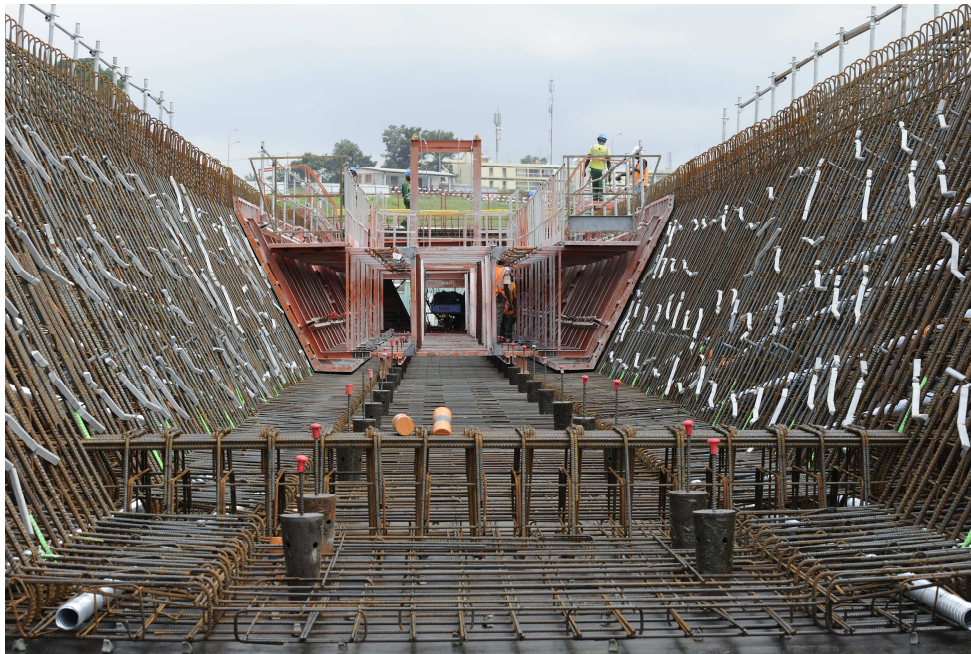
Fig.9. Coffrage intérieur des caissons ©photothèque BYTP
