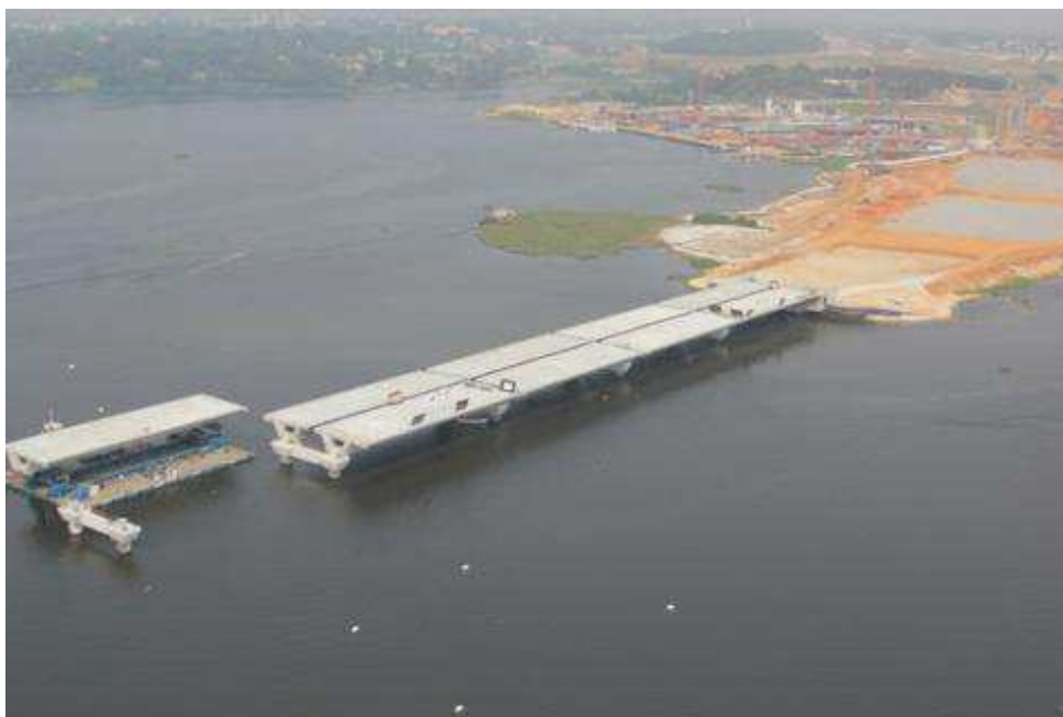
Fig.10. Pose d'un caisson ©photothèque BYTP
