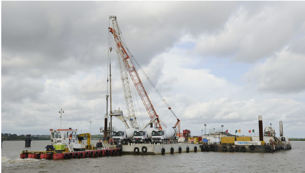
Fig.5. Injection du fond d'un pieu ©photothèque BYTP
