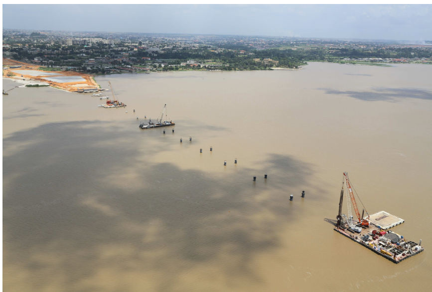
Fig.4. Réalisation des pieux ©photothèque BYTP
