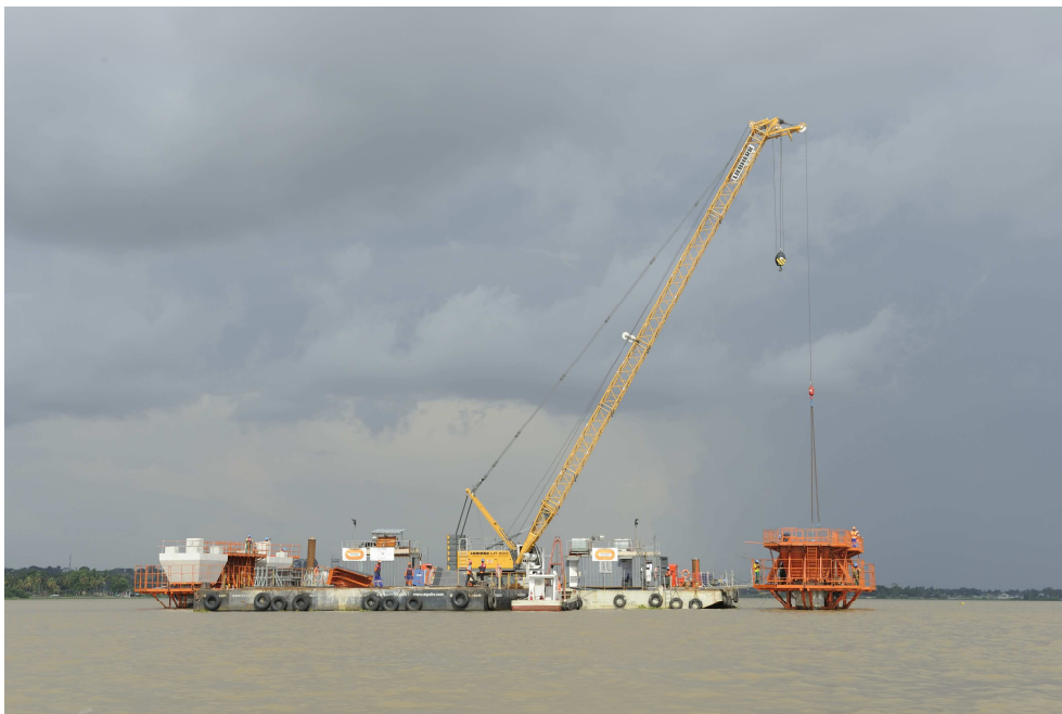
Fig.6. Coffrage d'un chevêtre ©photothèque BYTP
