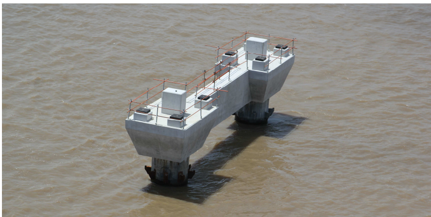
Fig.7. Tête de pile ©photothèque BYTP
