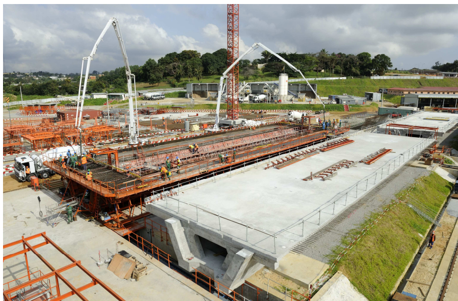
Fig.8. Lignes de préfabrication ©photothèque BYTP
