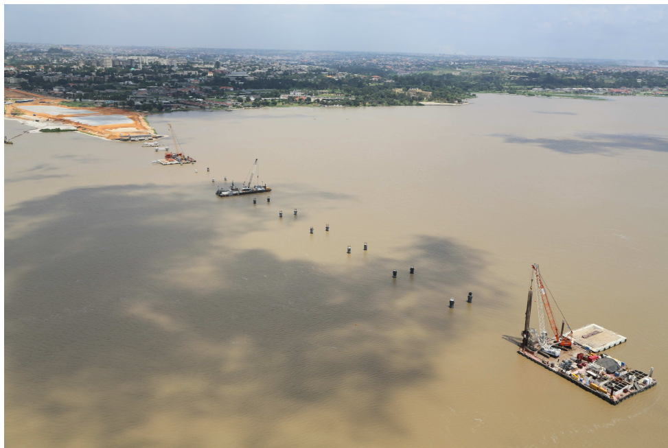
Fig.4. Piles execution ©photothèque BYTP
