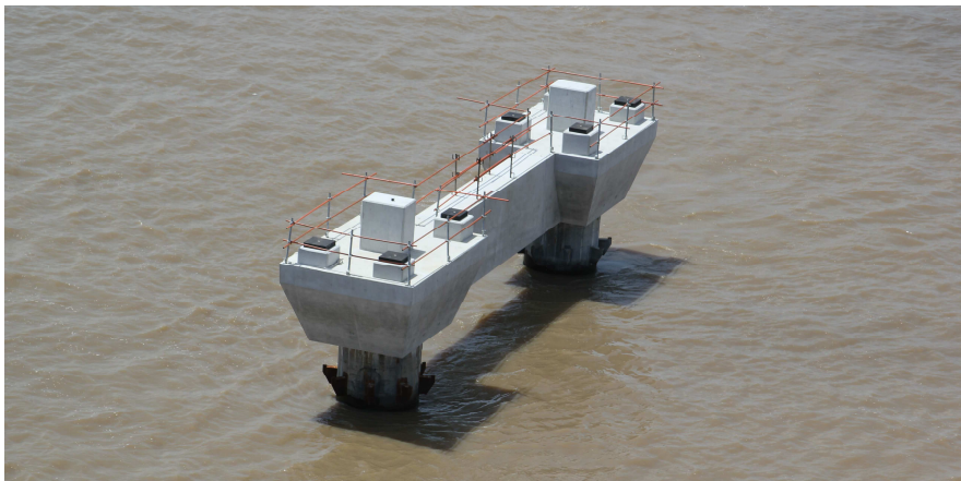
Fig.7. Pile cap ©photothèque BYTP
