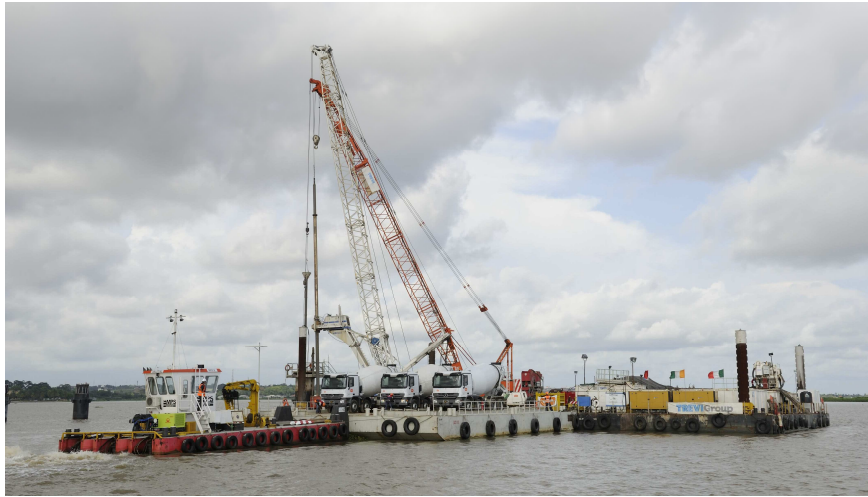
Fig.5. Pile grouting ©photothèque BYTP
