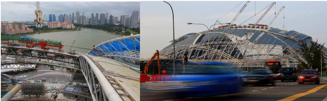
Fig. 18. Ripage du toit mobile en phase d'assemblage.
