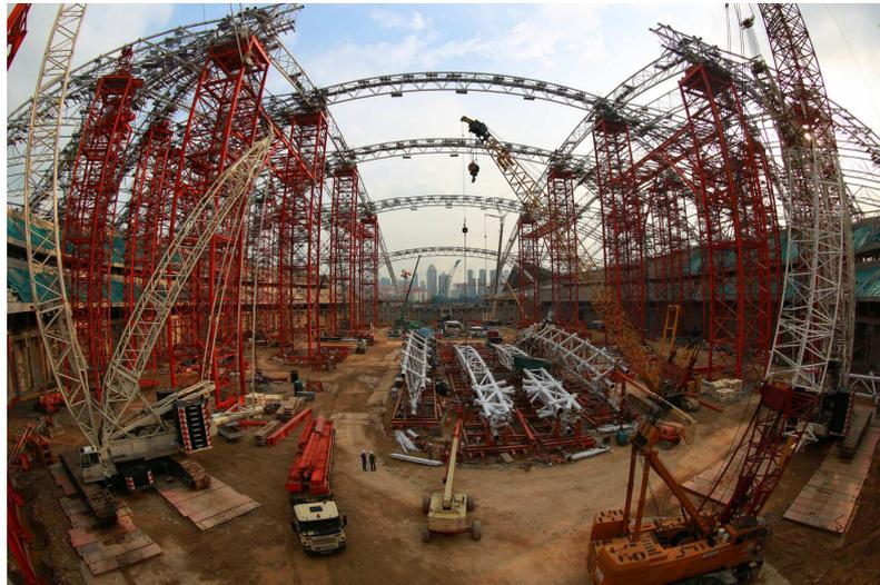
Fig. 15. Support de la structure sur appuis temporaires durant les phases de montage.
