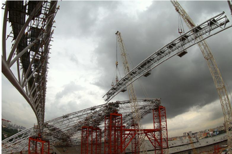
Fig. 14. Levage des sections centrales des arches avec 2 grues de 600 tonnes.
