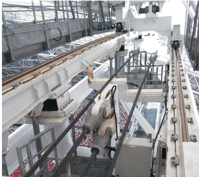
Fig.12. Chaque point ancrage est équipé avec une jauge de contrainte permettant de connaître avec précision les tensions dans les câbles.
