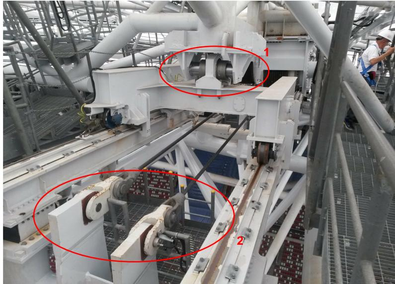
Fig.9. Appuis articulés et glissants (1) entre les bogies et la structure du toit mobile et points d'ancrage (2) des câbles sur le toit fixe.
