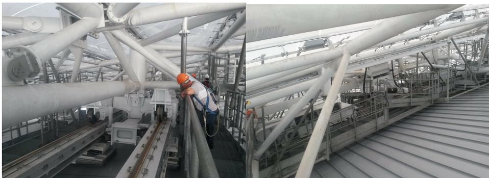
Fig.10. Plateformes d'accès à l'intérieur du toit mobile.
