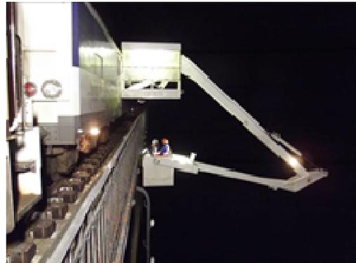
Figure 7 : Utilisation d'une nacelle négative sur wagon
