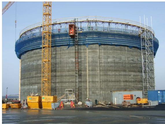
Figure 16 : l'opération du coffrage glissant
