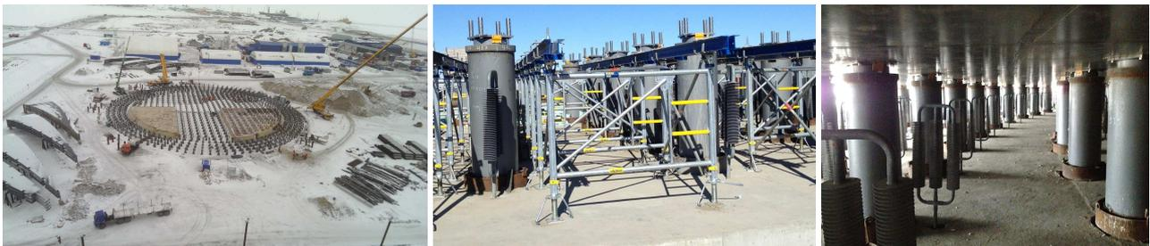
Figures 14 : les thermo-stabilisateurs placés entre chaque pieu, la dalle et le radier surélevé
