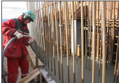
Figure 18 : coulage de la partie haute du voile
