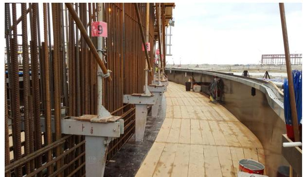
Figures 17 : coupe du coffrage et plateforme de coffrage
