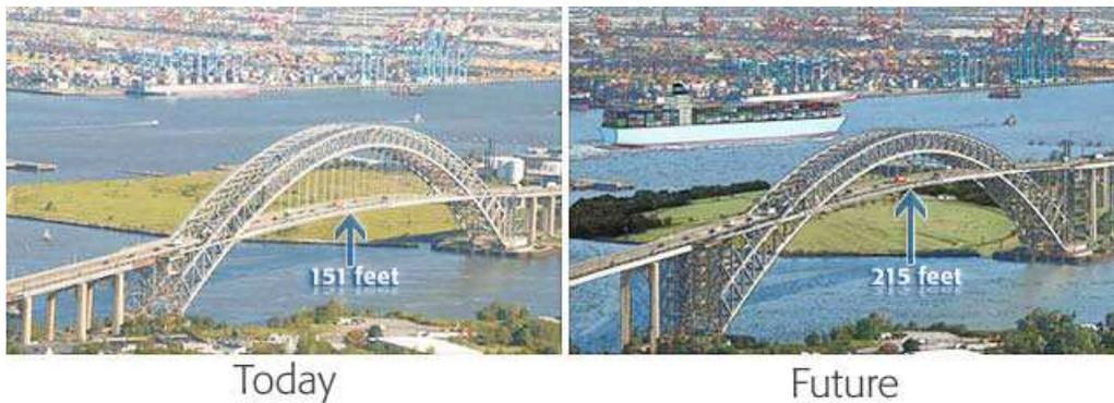
Figure 10. Le Pont de Bayonne : avant-après
