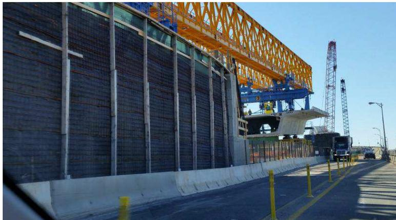
Figure 3: Mur provisoire TerraTre® en treillis soudé pour la phase 1
