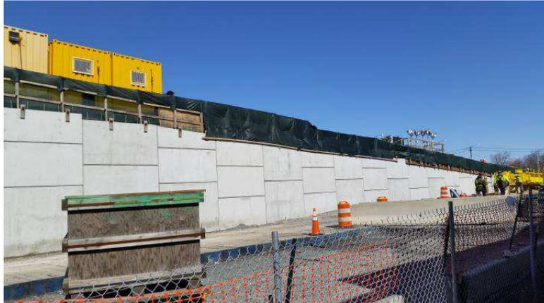
Figure 2: Mur en Terre Armée® avec panneaux de parement rectangulaires
