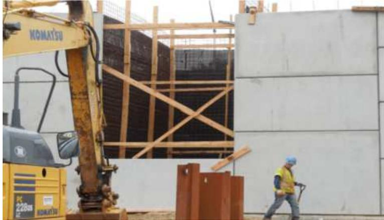
Figure 8. « Réservation » en Terratrel® pour l'installation de la Terre Armée
