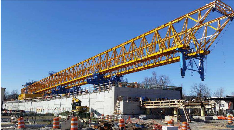
Figure 6. Poutre de lancement en porte-à-faux
